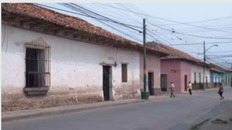
► Espacio urbano antes de la intervención
