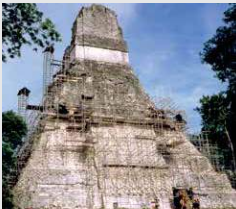
► Parte posterior del Templo I, en proceso de restauración
