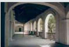
• Galerías del claustro antes de la intervención
