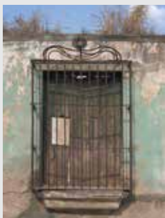
► Ventanas características de Comayagua, antes de la intervención
