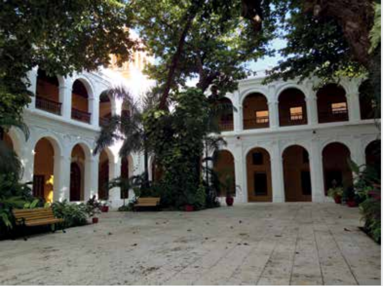
► Claustro después de la restauración
