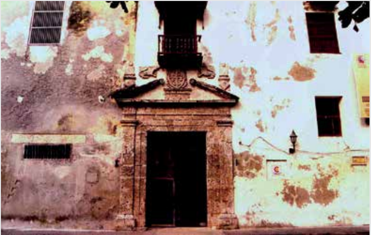
• Convento de Santo Domingo antes de la intervención
