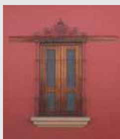
► Arriba: Portal Los Encuentros, Casa Cultural Comayagüense. Abajo: Ventana característica de Comayagua restaurada
