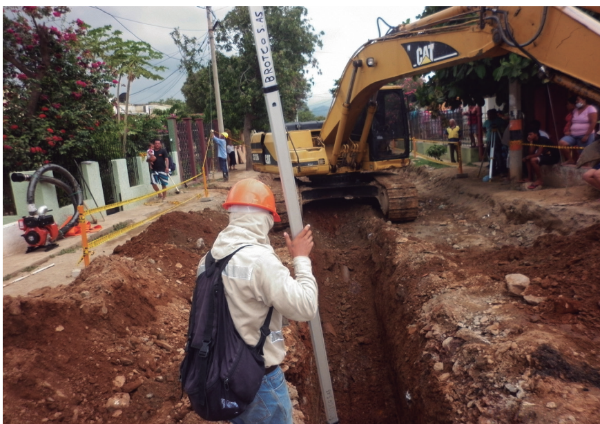
Imagen 7: Obras de conexión pluvial en Santa Marta
