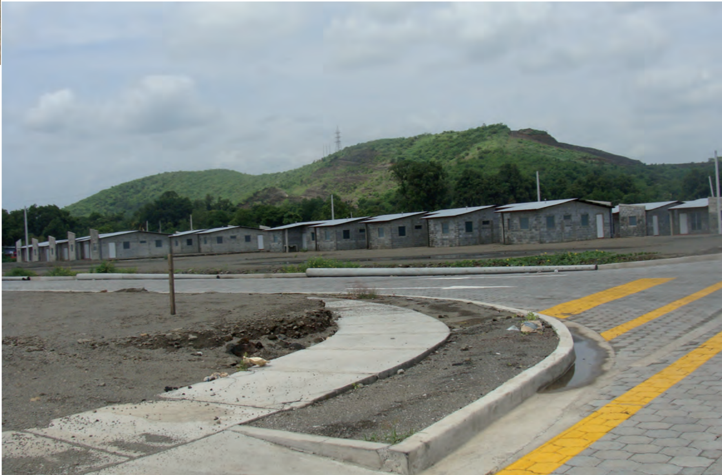
Barrio de La Chureca en proceso de construcción.
