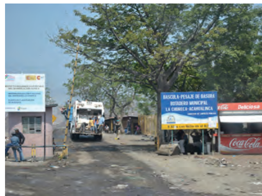
Entrada al vertedero antes de la intervención.
