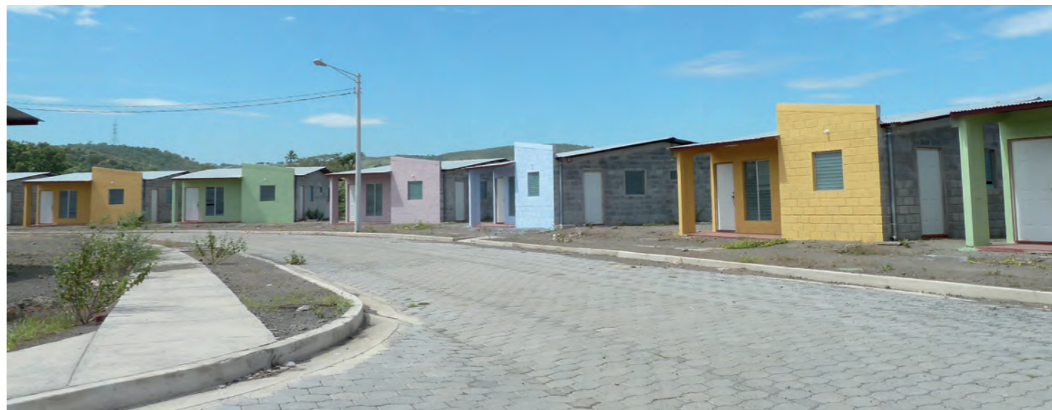
Barrio de La Chureca en proceso de construcción.
