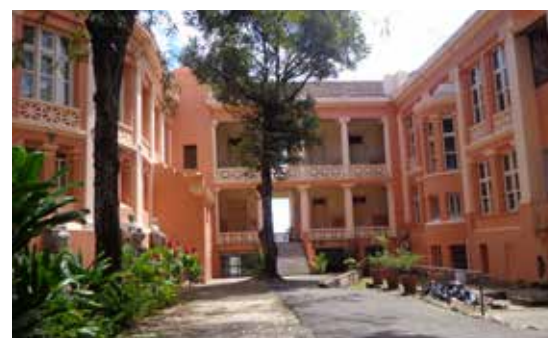
Facultad de Medicina. Edificio de la Biblioteca. ▶ Antes y después de la intervención
