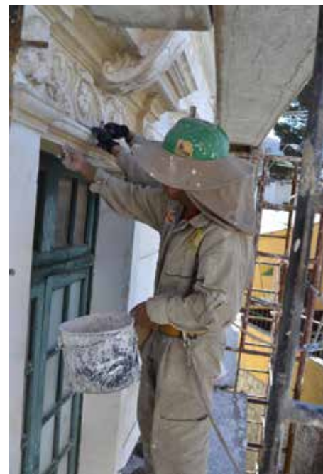
▲ Escuela Brasil. Taller de albañilería
