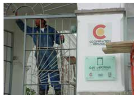
▲ Antigua Hospital Militar - Pabellón 3. Antes y después de la intervención ▼ Antigua Hospital Militar - Ingreso. Taller de herrería
