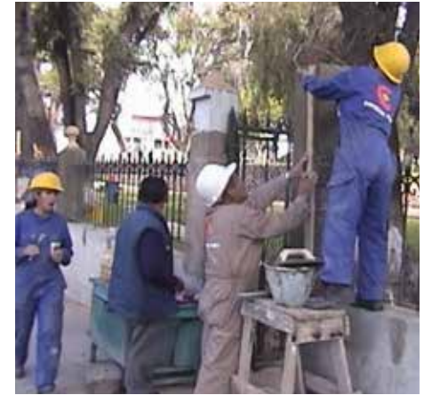
▲ Espacios públicos. Taller de albañilería
