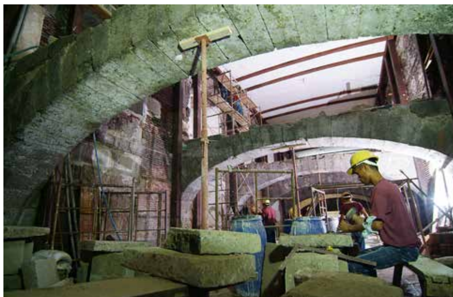
◀ Práctica en obra de cantería
