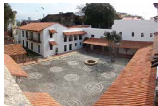
▼ Claustro del Convento de Santo Domingo. Antes, durante y después de la intervención.
