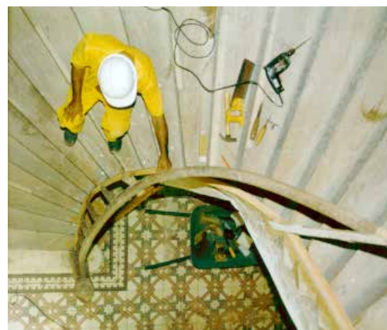
▼ Práctica de obra de carpintería
