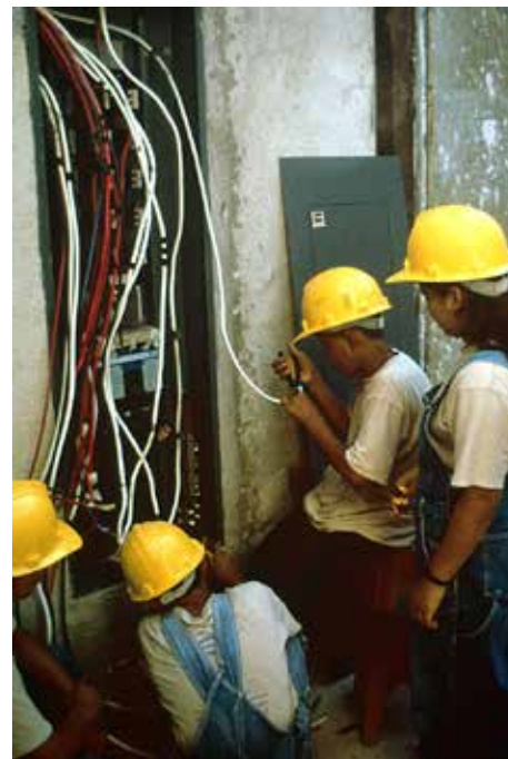
▲ Práctica de obra taller de electricidad
