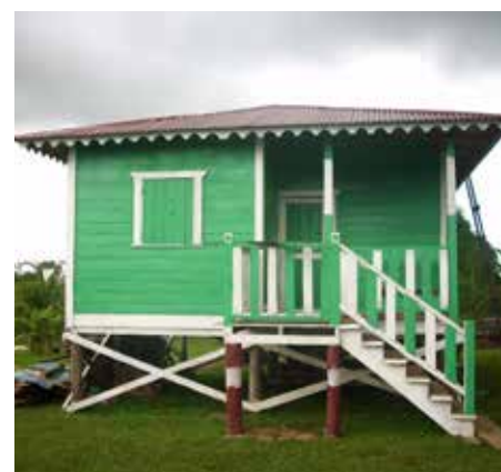
▼ Casa reconstruida por jóvenes de la ET en Tuara
