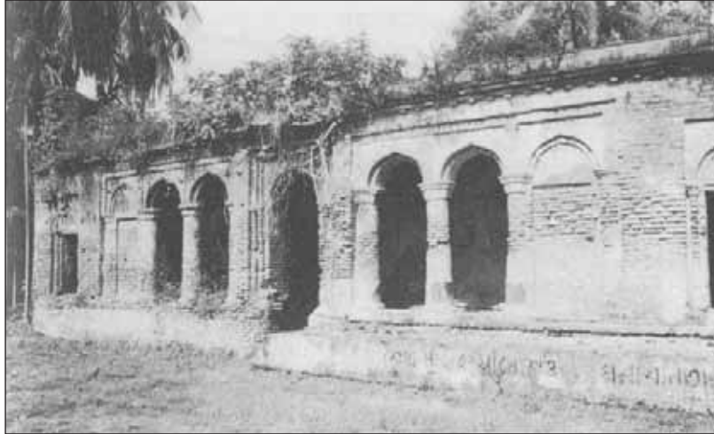
La antigua casa familiar en Tungipara
