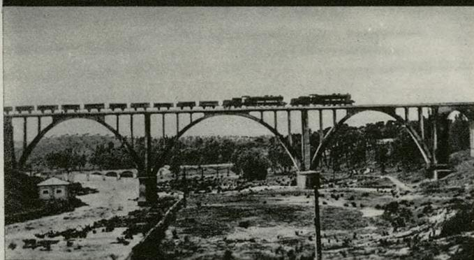
Puente de Huezna, con el tren de prueba.
