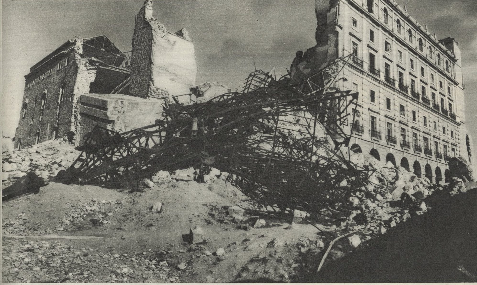
La primera mina, seis toneladas de dinamita bajo el torreón S. O., derrumbó todo un ángulo del castillo toledano. Sobre la ciudad llovió piedra durante minuto y medio
