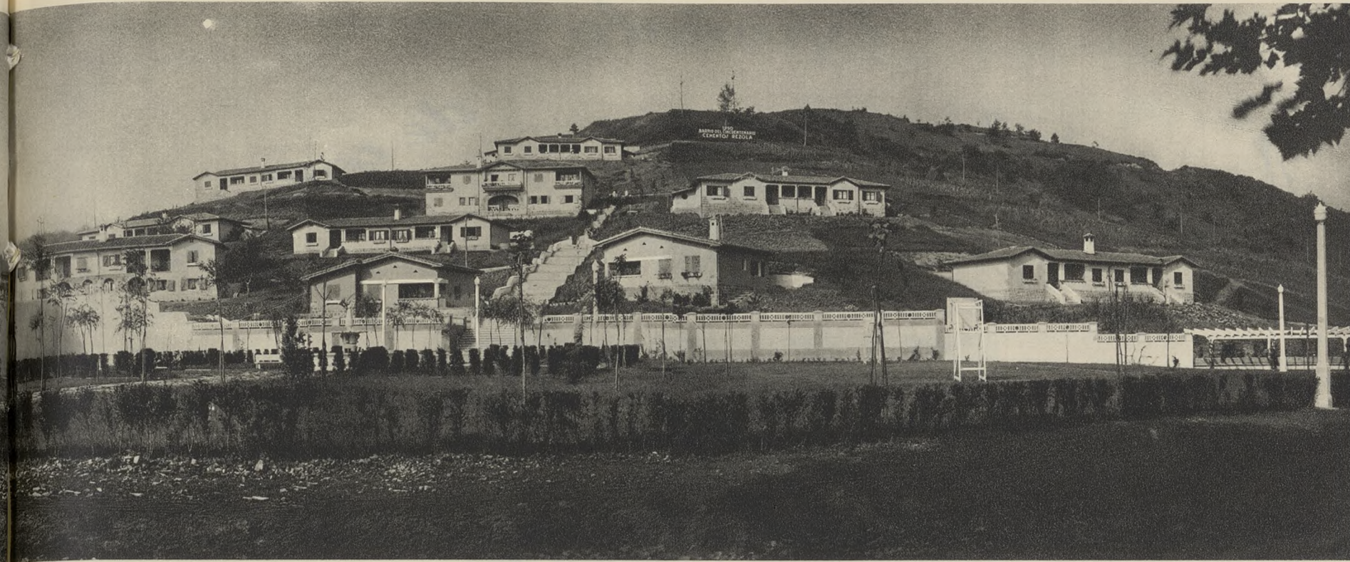
de casitas para obreros y empleados, denominado «barrio del Cincuentenario, 1950».
