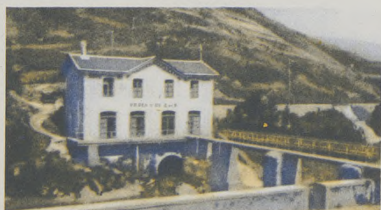
Vista de una de las centrales hidroeléctricas de «Orbea y Cía.», casa fundada en 1840, y que en ese siglo largo de existencia ha alcanzado prestigio universal.
