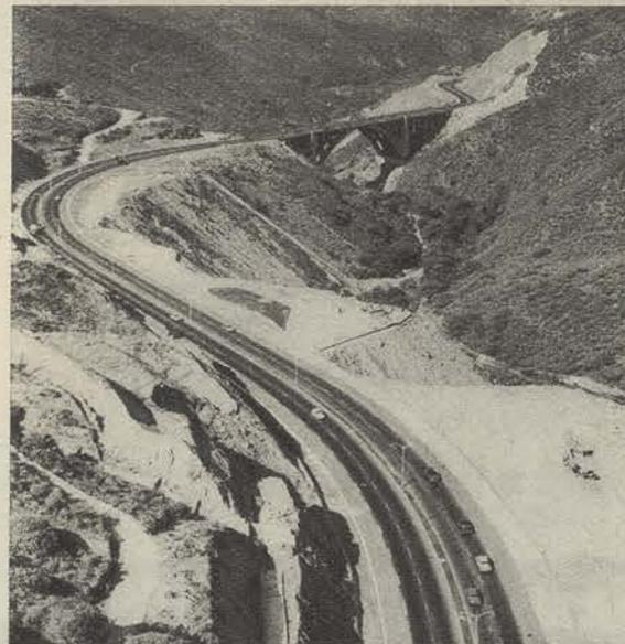
tañas en dos túneles de doble servicio, diseñados con sujeción a las más modernas normas de la técnica, y salvar las profundas quebradas con tres grandes viaductos. Las nivelaciones, que en ocasiones presentan rellenos de 45 metros y cortes hasta de 95, son también obras de gran magnitud que merecen especial mención. En contraste con la vieja carretera, que tiene 395
