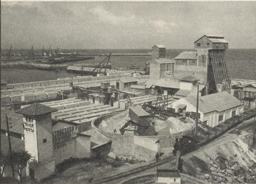
Instalación para la ejecución de los bloques de hormigón en las obras de ampliación del puerto de El Musel-Gijón.
