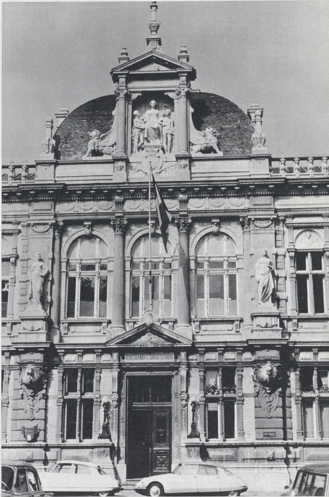
Aspecto actual del antiguo edificio del Instituto de Altos Estudios Mercantiles de Amberes.
