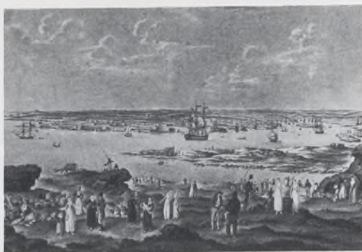
«Vista de Puerto Mahón, tomada de la parte de Cabo Mola. Año de 1770.»
