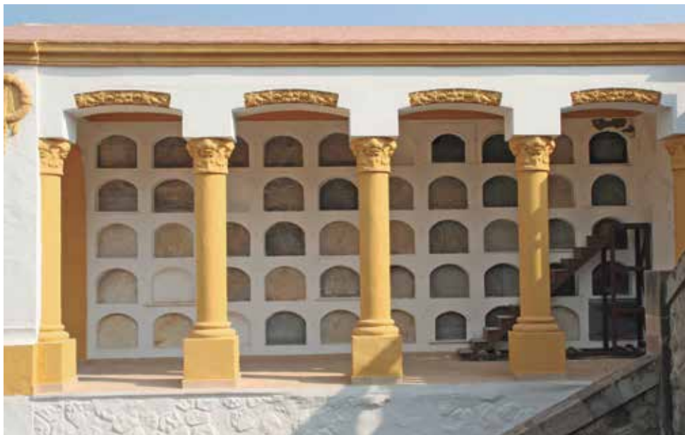
Melilla, galería exterior derecha, fotografía fotografía A. Bravo.
