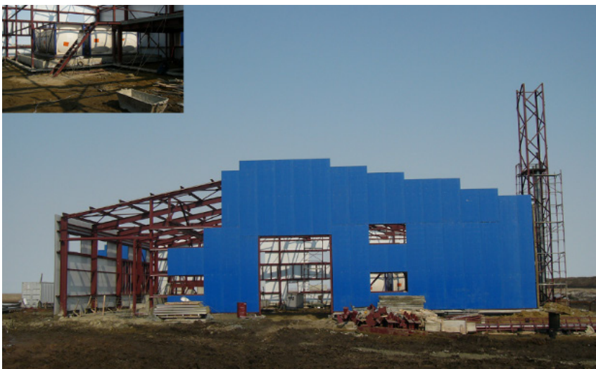
Construcción de la planta de Varvarinskaya.
