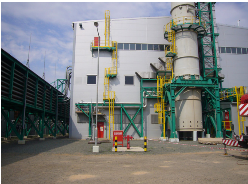
Planta generadora de energía 80 MW CTCA, en Atyrau, Kazajstán, diseñada por IDOM.
