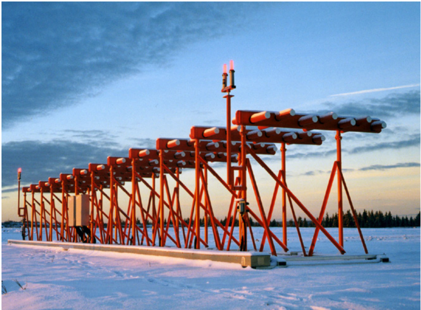
INDRA. Sistema de aterrizaje por instrumentos_ILS NORMARC -ret.
