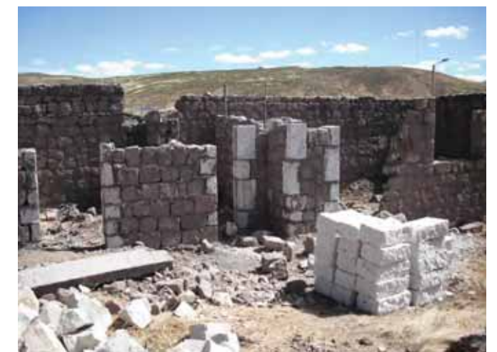
Avance de obra
