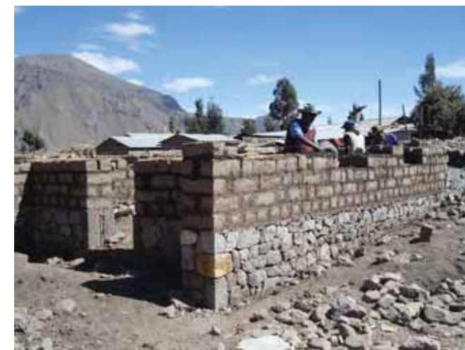
Avance de obra
