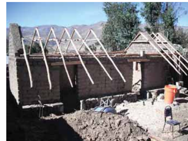
Avance de obra
