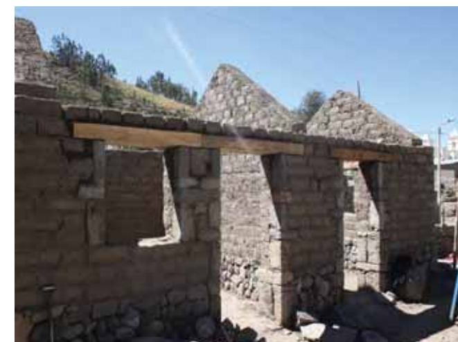
Avance de obra
