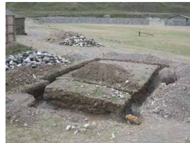
Avance de obra
