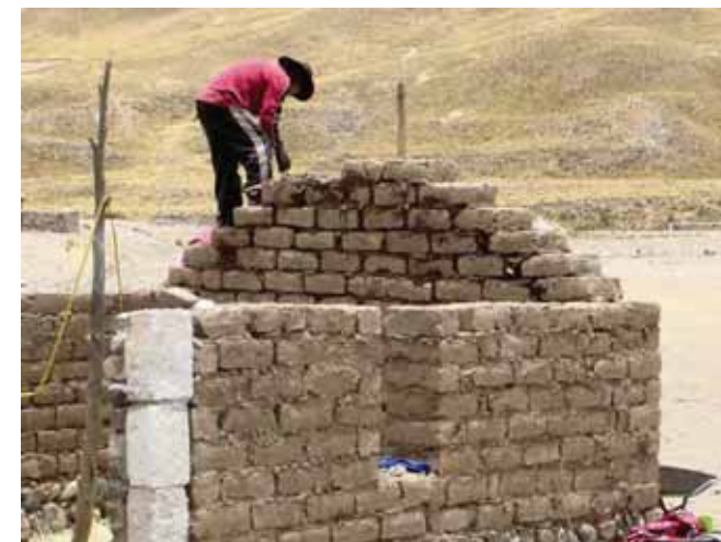
Avance de obra
