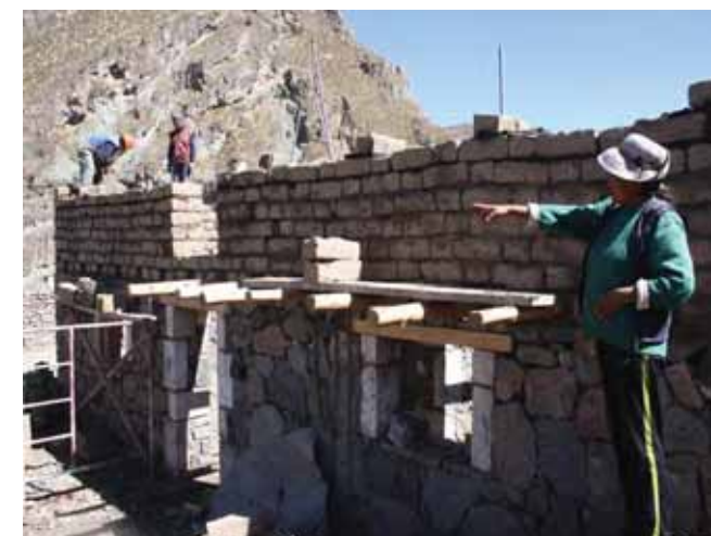
Avance de obra
