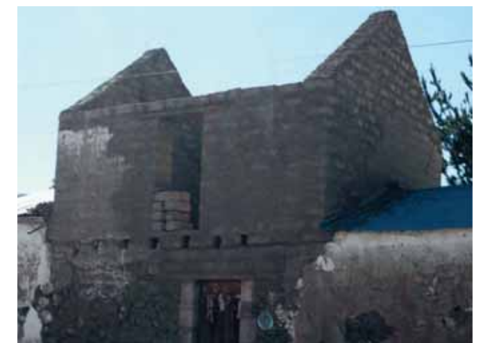
Avance de obra
