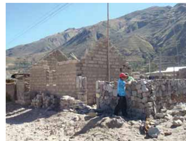
Avance de obra
