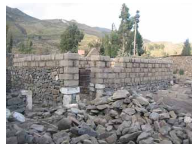
Avance de obra
