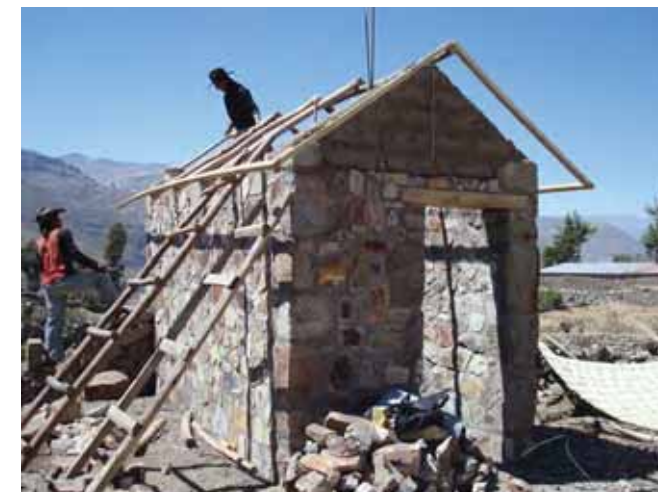
Avance de obra
