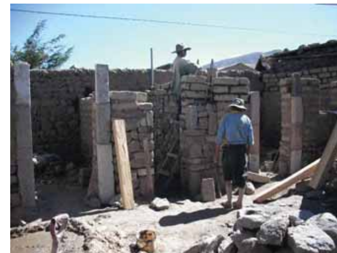
Avance de obra
