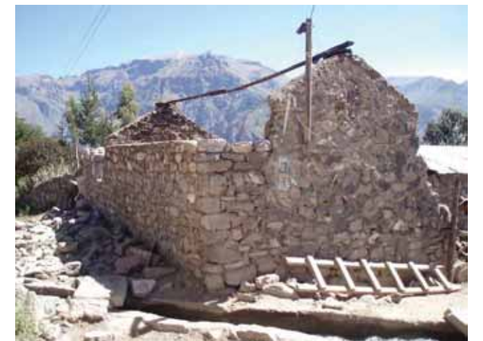
Avance de obra
