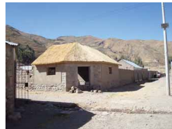
Avance de obra
