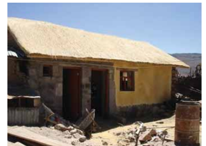
Avance de obra
