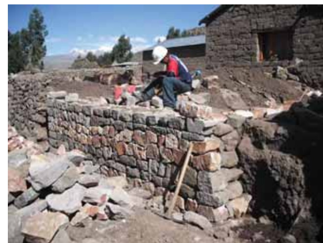
Inicio de obra
