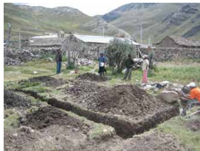
Avance de obra
