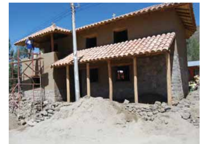
Avance de obra
