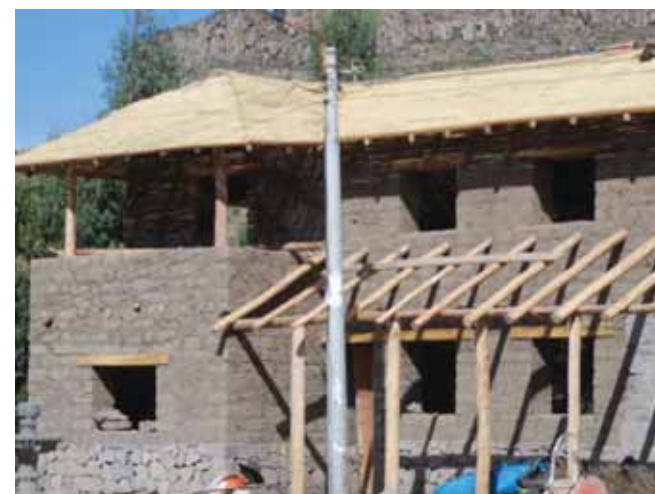
Avance de obra
