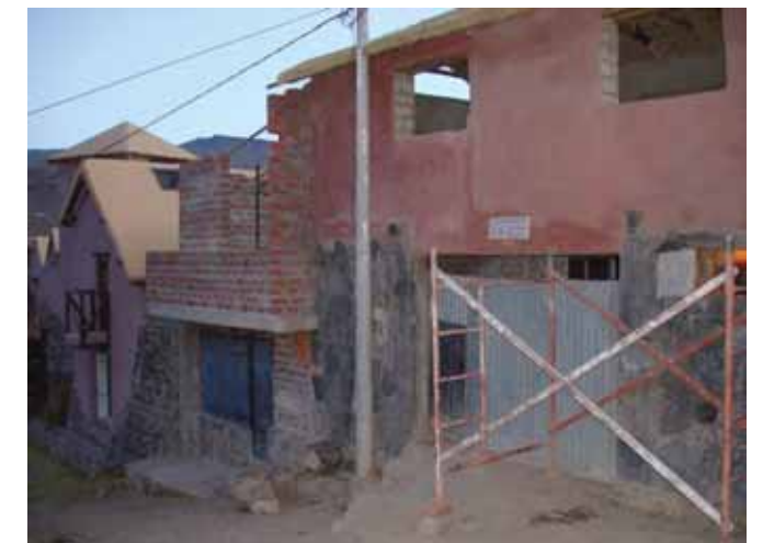
Avance de obra
