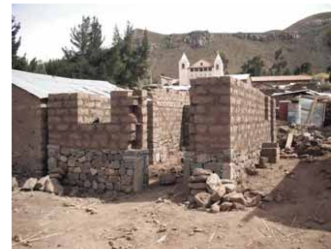
Avance de obra
