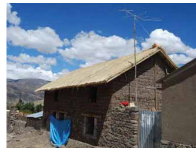
Avance de obra
