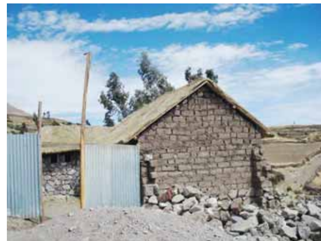
Avance de obra
