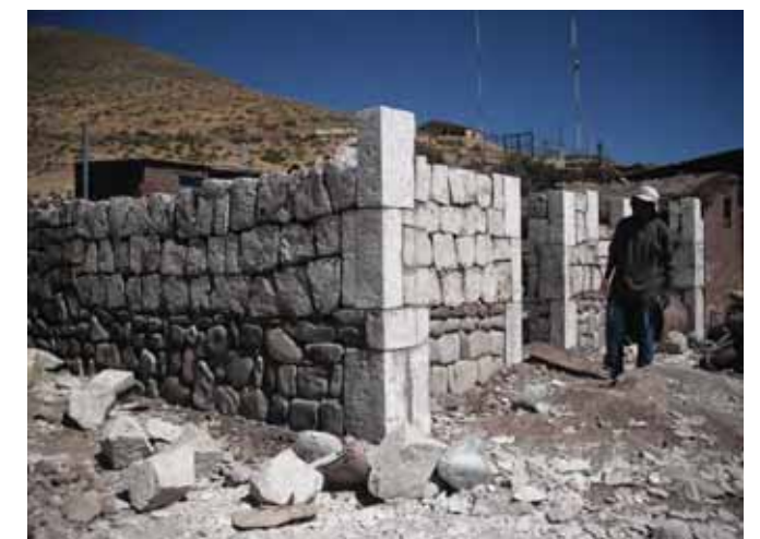
Avance de obra
