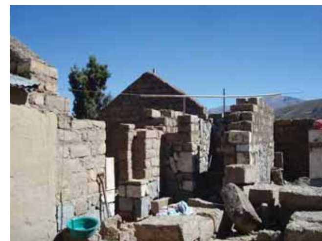
Avance de obra
