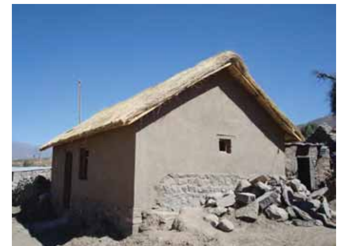
Avance de obra
