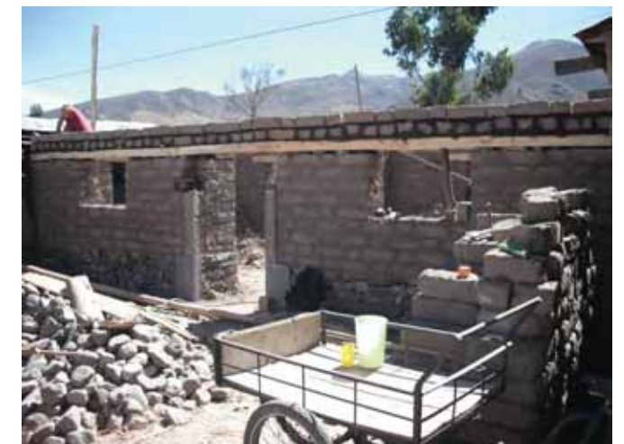
Avance de obra
