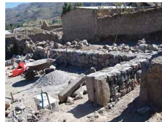
Avance de obra
