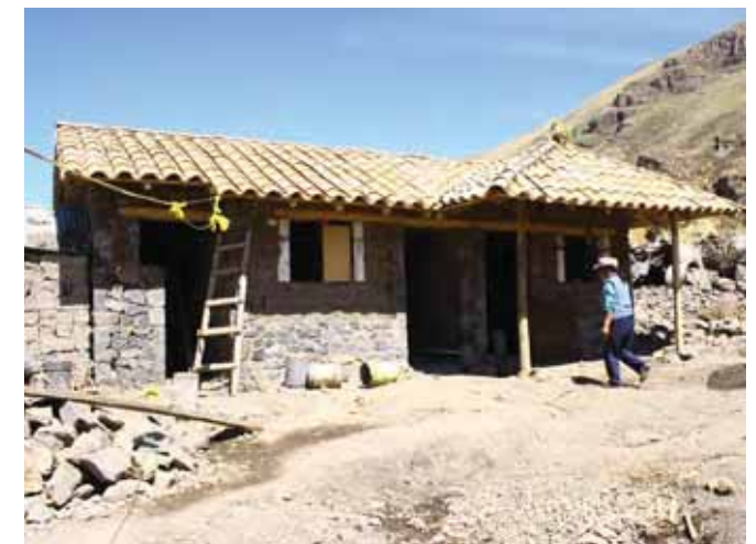
Avance de obra
