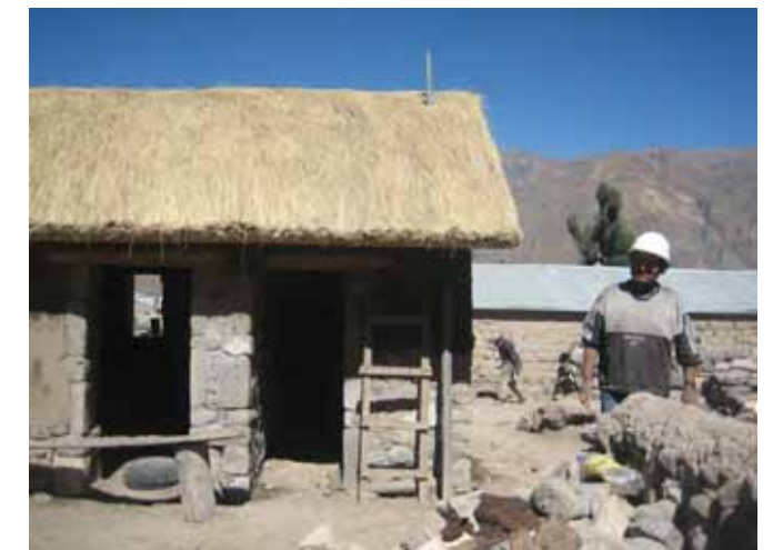
Avance de obra
