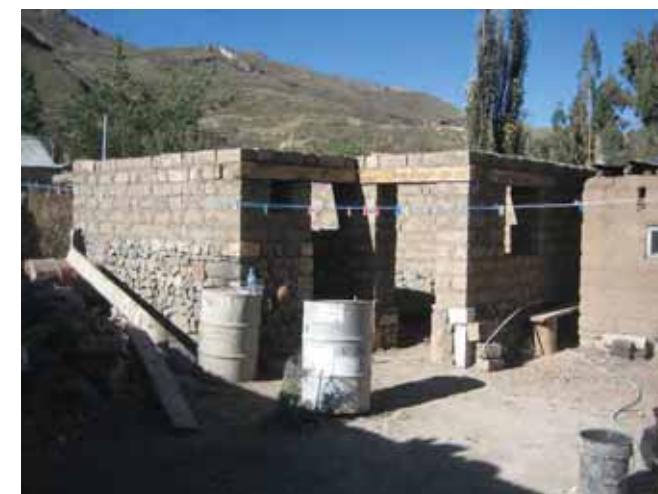
Avance de obra
