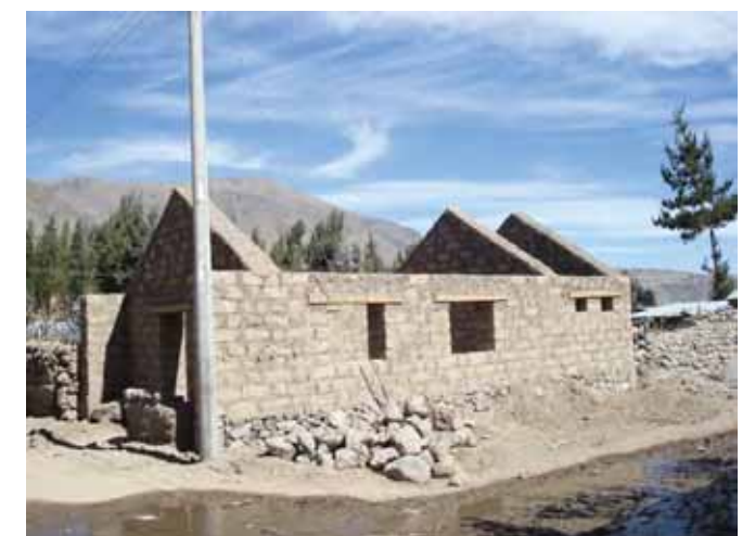
Avance de obra
