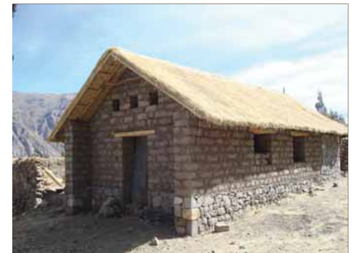
Avance de obra
