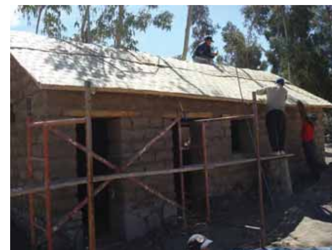
Avance de obra
