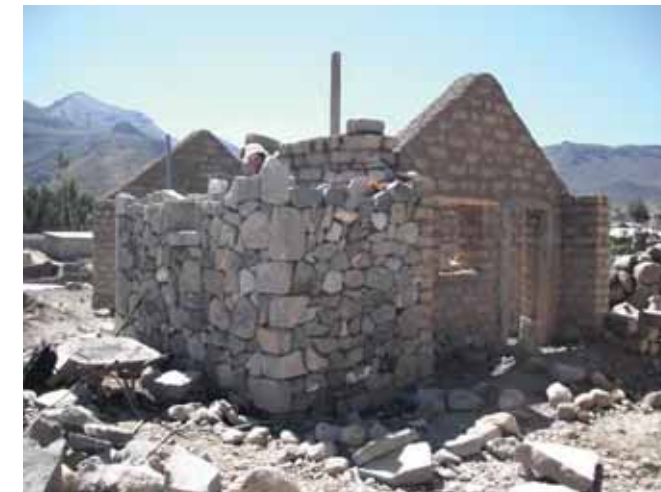
Avance de obra
