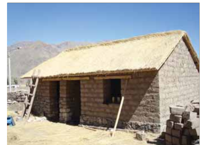
Avance de obra
