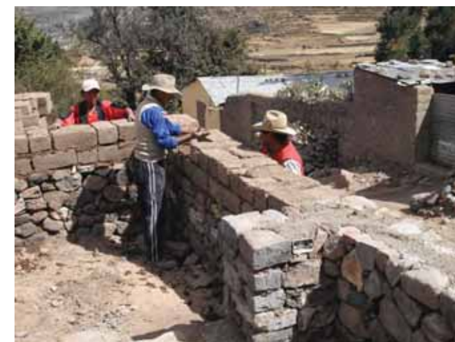
Avance de obra
