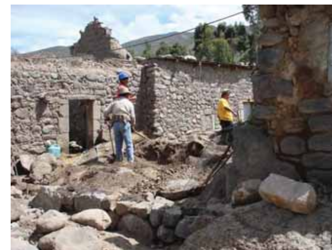
Avance de obra
