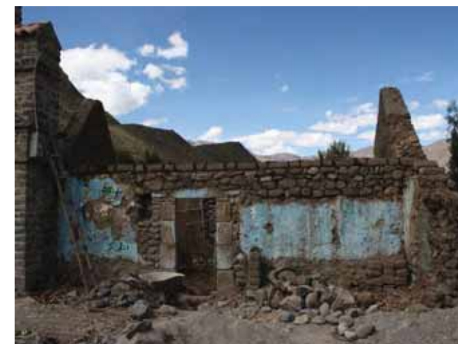
Avance de obra
