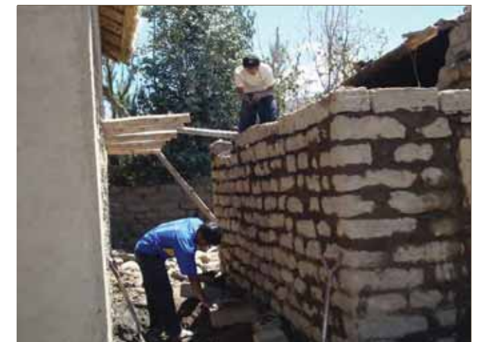
Avance de obra
