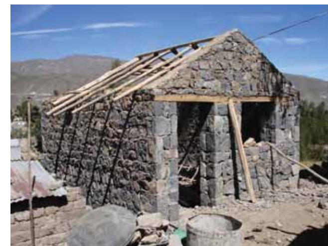
Avance de obra
