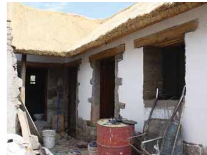
Avance de obra
