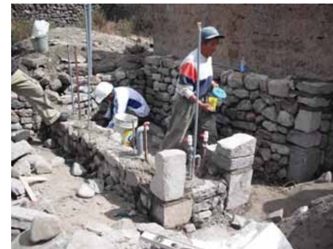
Avance de obra
