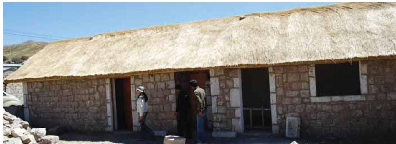
Avance de obra
