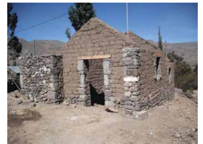
Avance de obra
