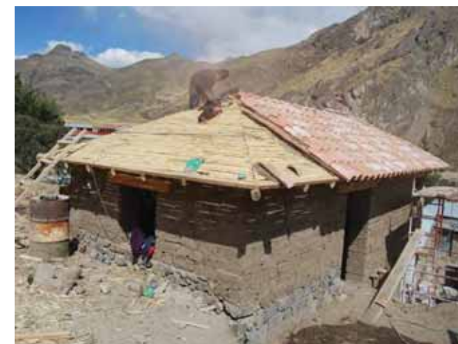
Avance de obra
