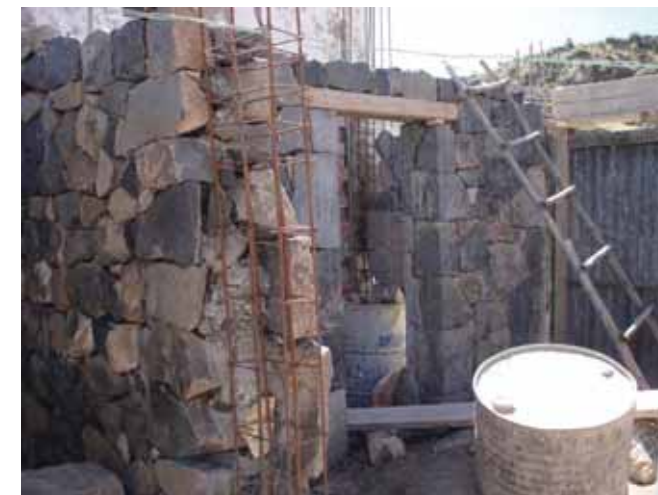
Avance de obra
