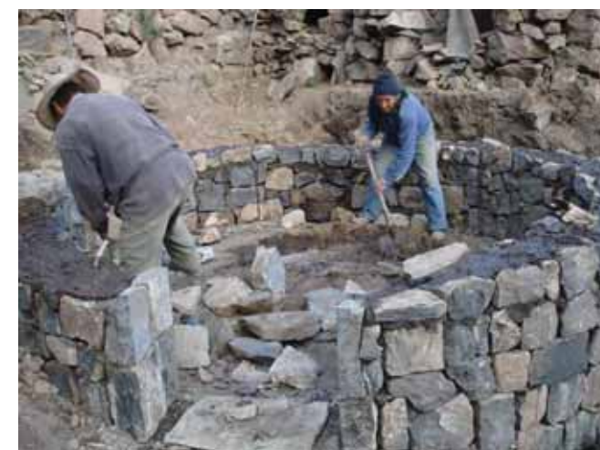
Avance de obra
