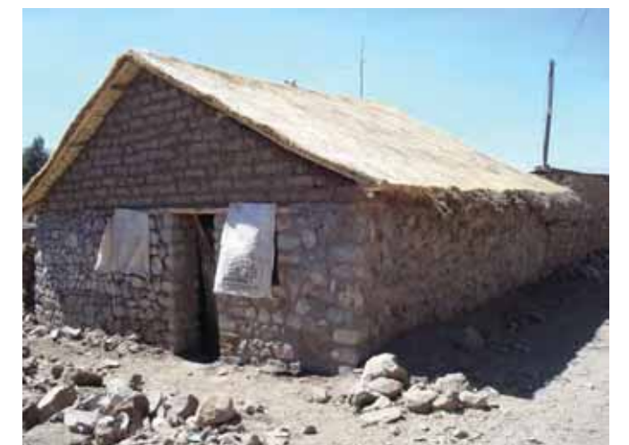
Avance de obra
