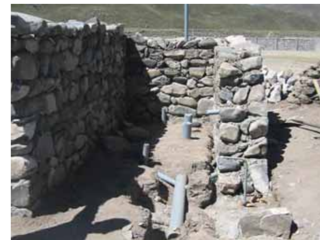
Avance de obra
