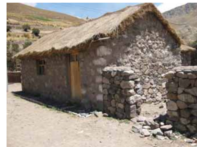
Avance de obra
