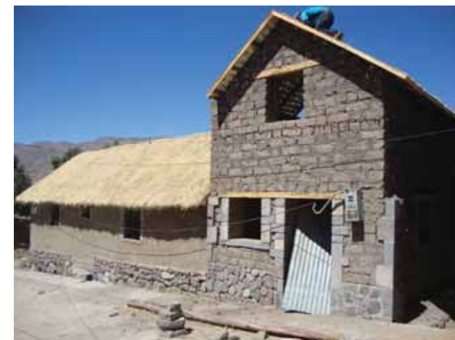
Avance de obra
