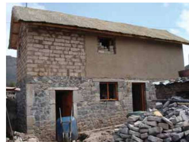
Avance de obra
