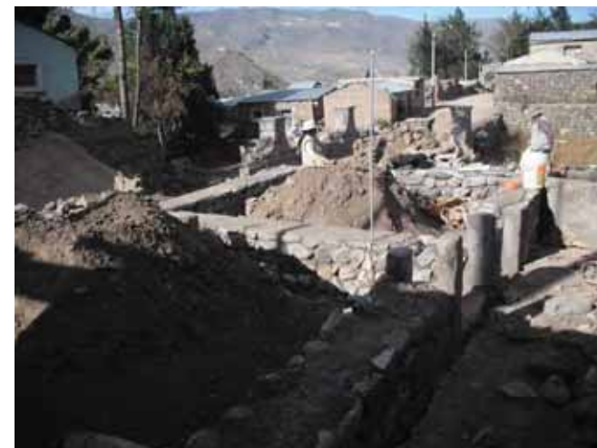
Inicial de Obra
