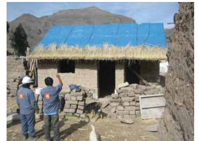
Avance de obra
