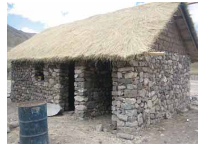
Avance de obra
