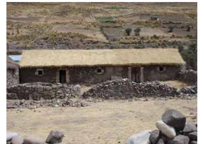
Avance de obra
