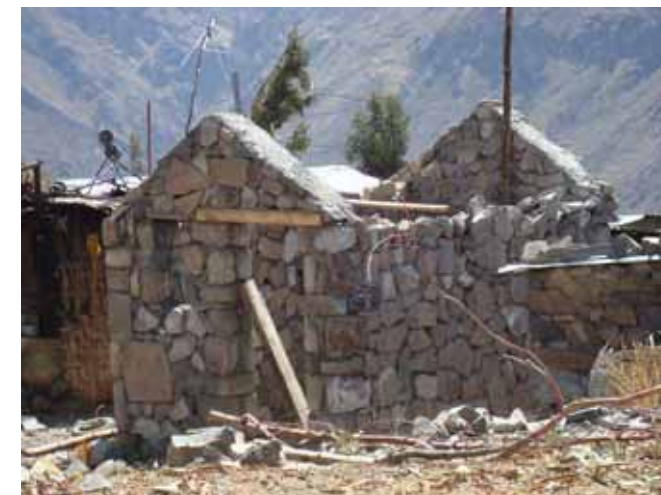
Avance de obra
