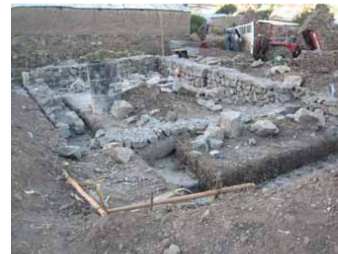
Avance de obra
