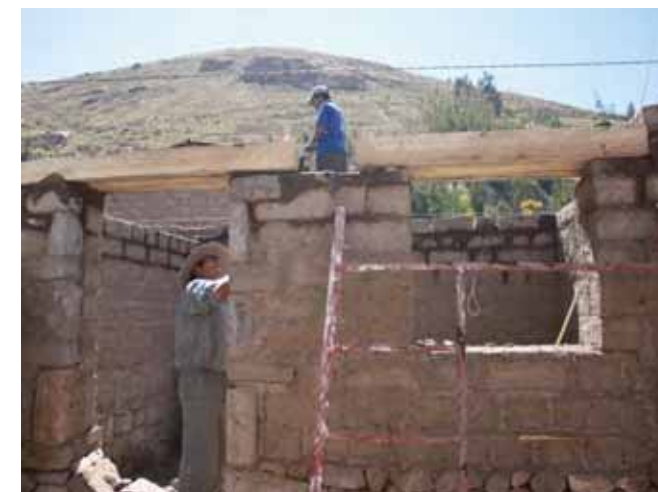
Avance de obra
