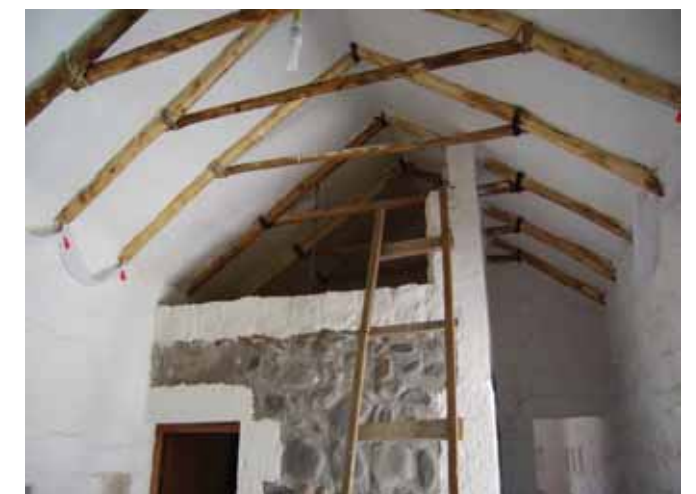
Avance de obra
