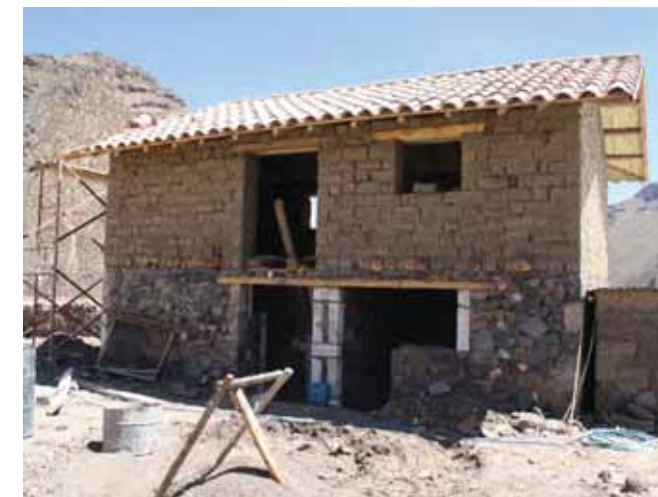
Avance de obra
