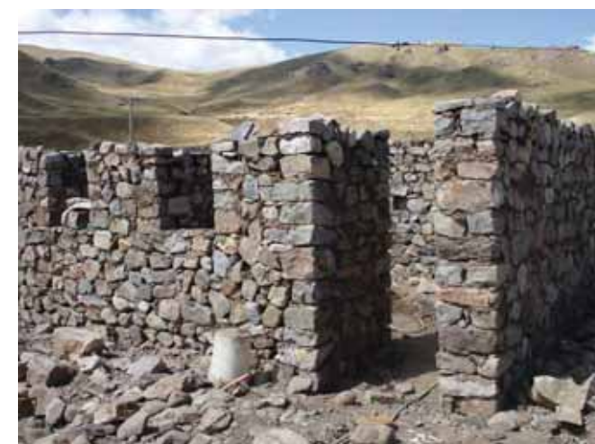
Avance de obra
