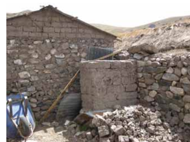
Avance de obra
