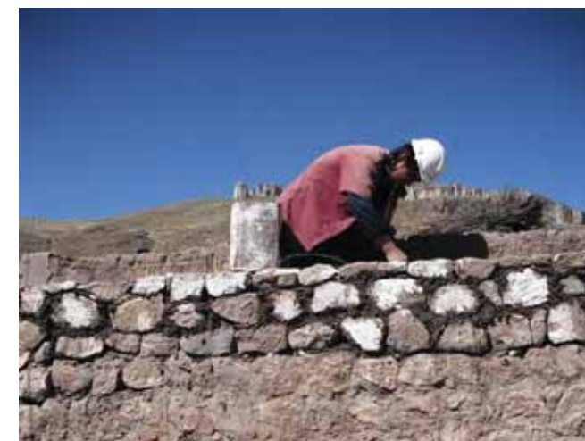
Avance de obra
