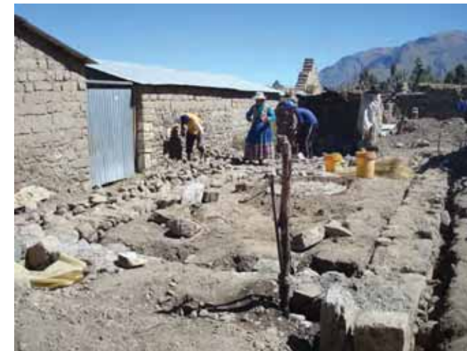
Avance de obra
