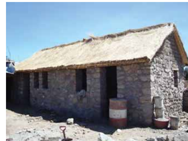
Avance de obra
