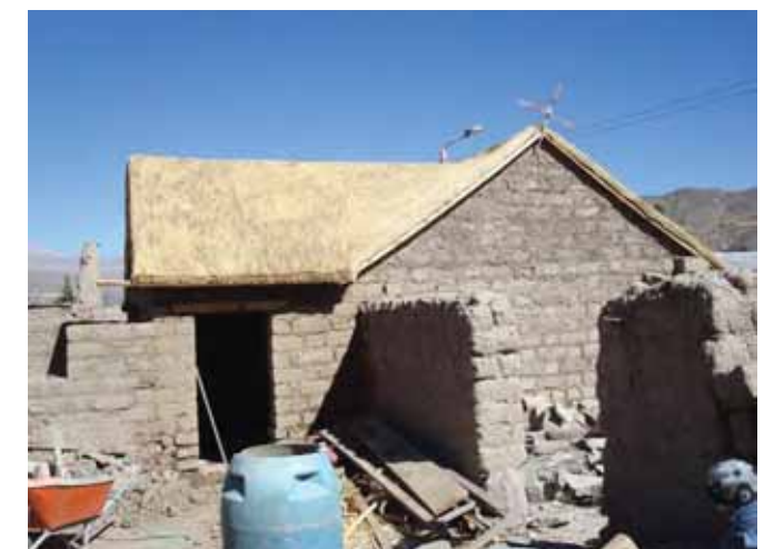
Avance de obra
