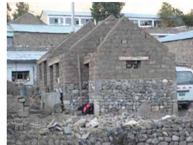
Avance de obra
