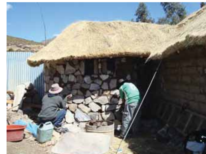
Avance de obra
