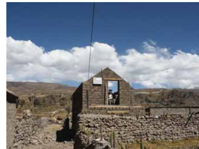
Avance de obra
