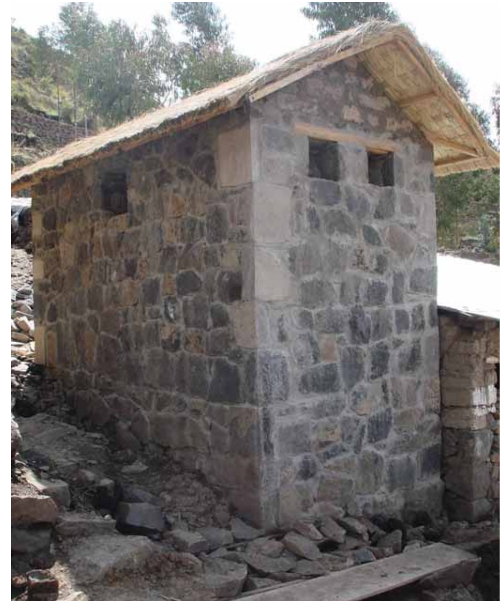
Servicios Higiénicos concluida
