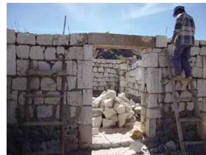
Avance de obra
