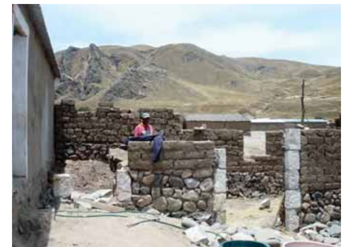
Avance de obra
