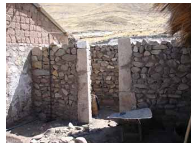
Avance de obra
