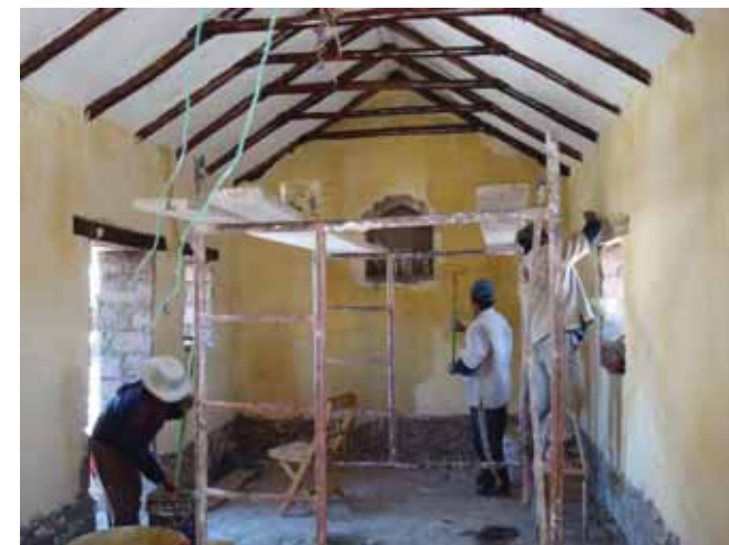
Avance de obra
