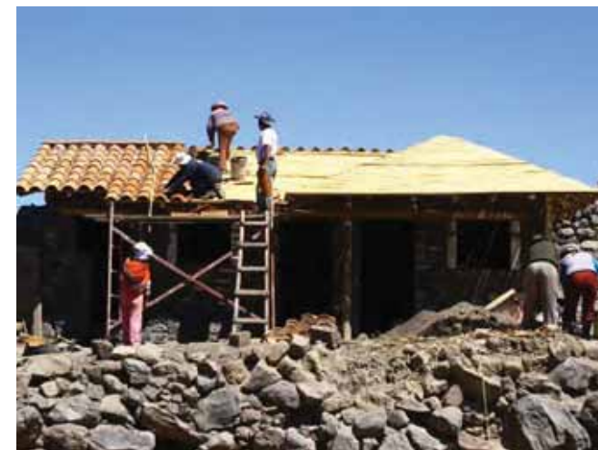
Avance de obra
