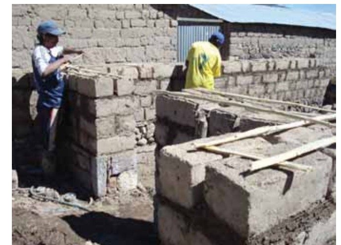
Avance de obra
