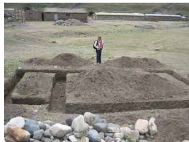
Avance de obra
