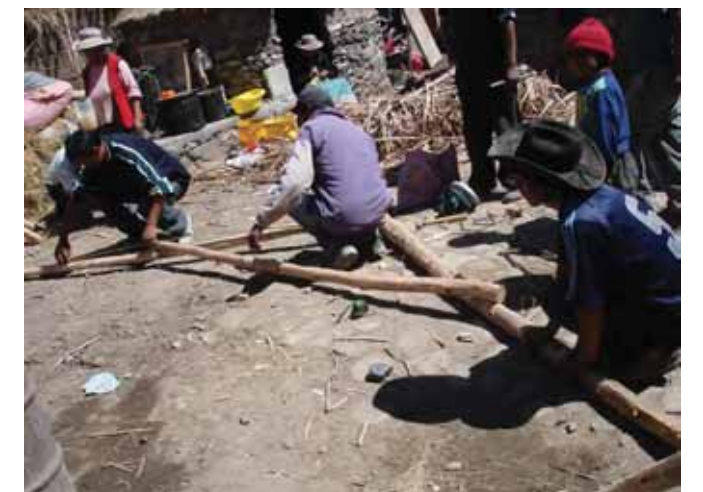
Avance de obra
