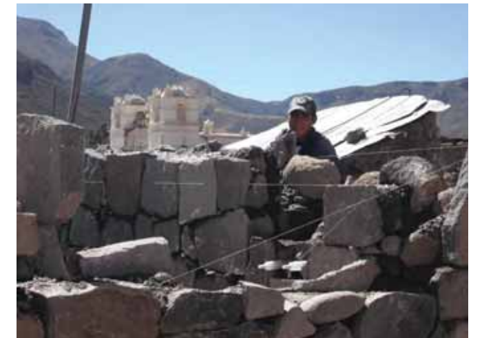
Avance de obra
