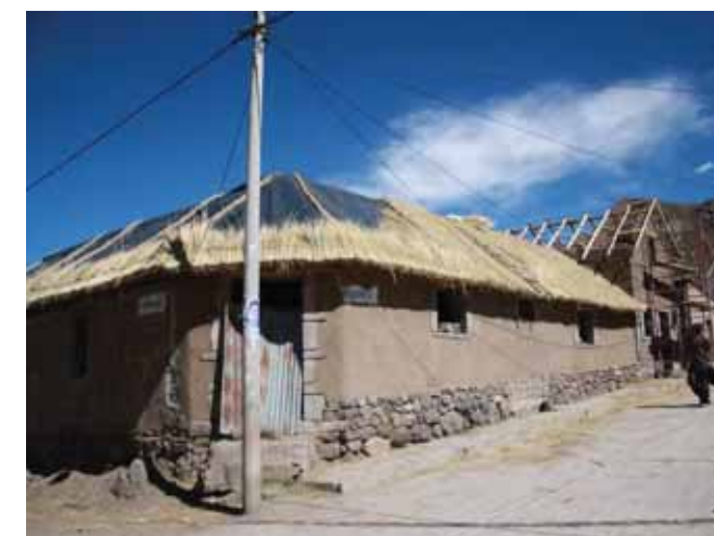
Avance de obra
