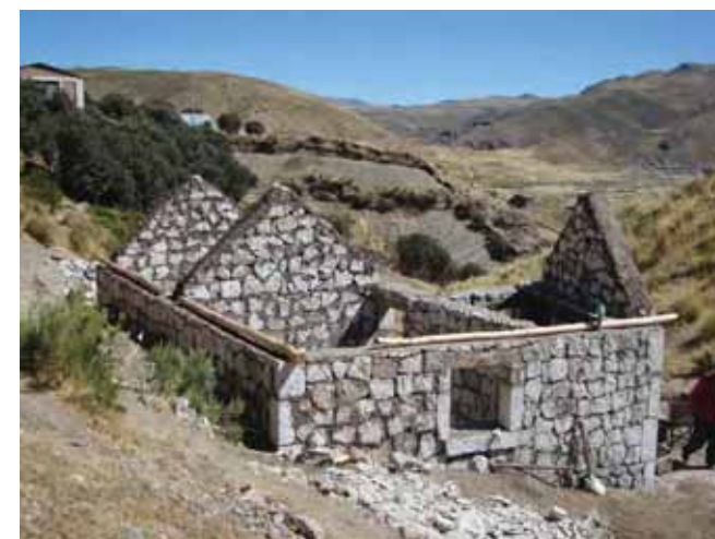
Avance de obra
