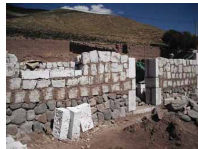
Avance de obra
