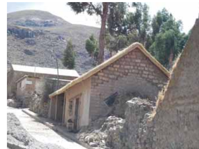
Avance de obra
