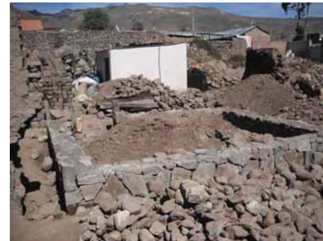
Avance de obra
