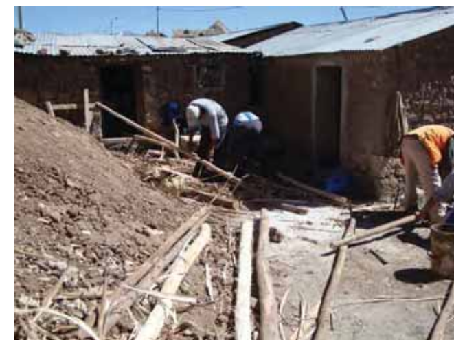
Avance de obra
