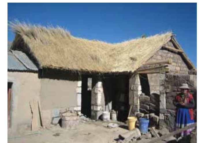
Avance de obra
