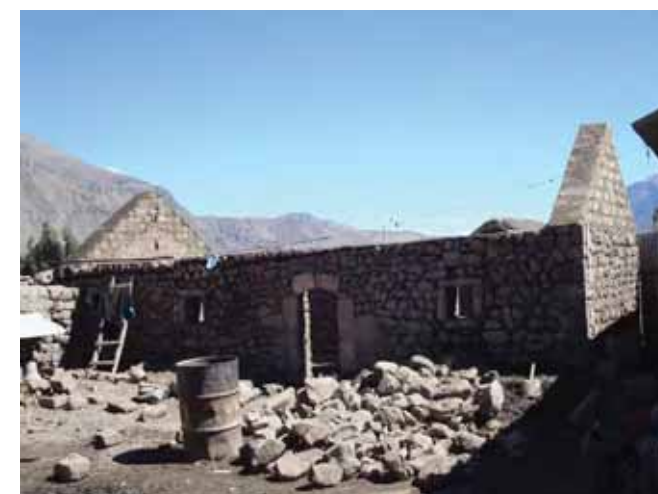
Avance de obra
