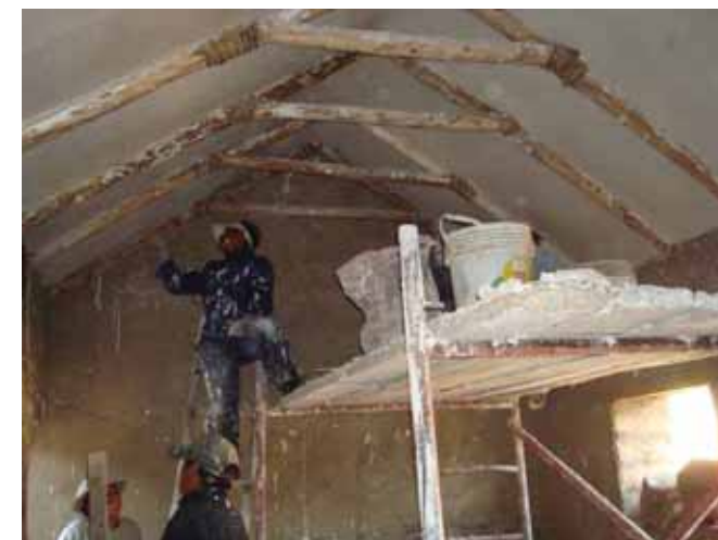
Avance de obra
