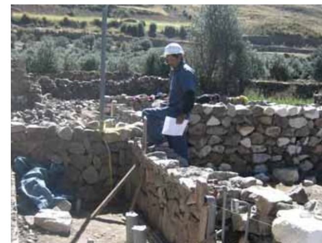
Avance de obra
