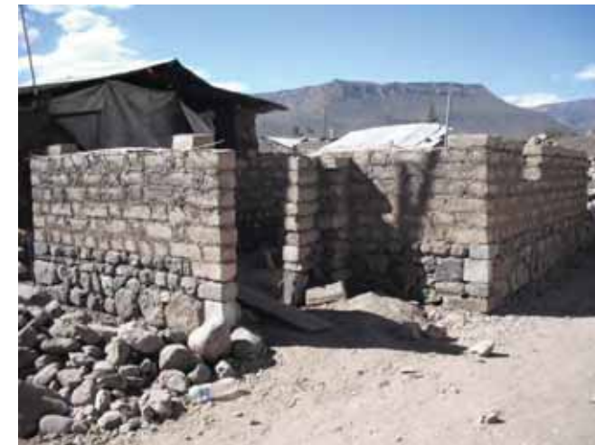
Avance de obra
