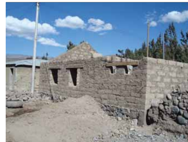
Avance de obra
