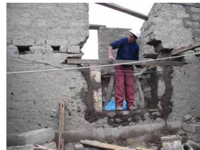
Avance de obra
