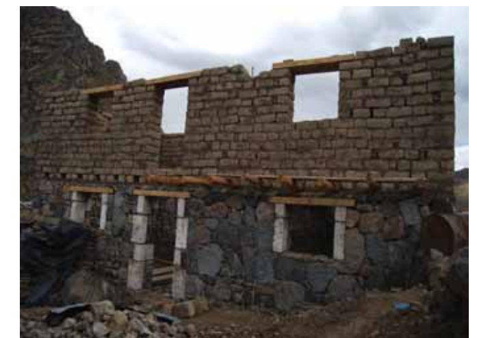
Avance de obra
