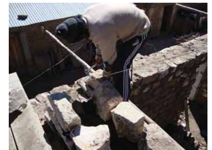
Avance de obra
