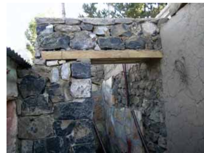
Avance de obra
