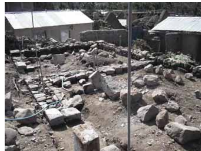
Inicio de obra
