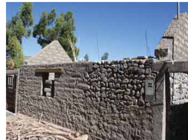
Avance de obra
