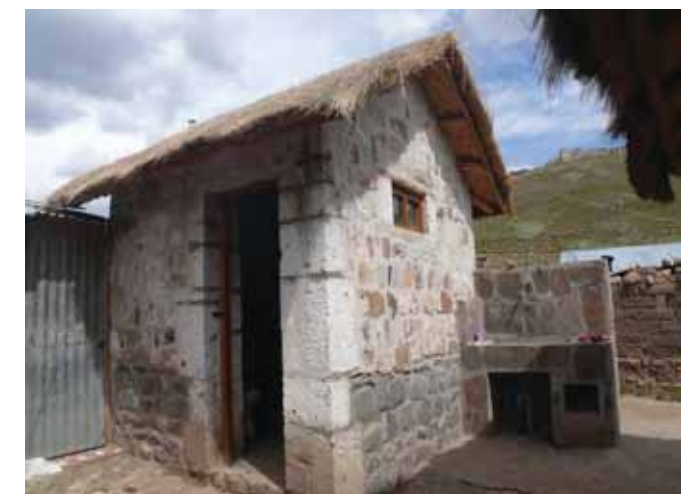
Servicios Higiénicos concluidos
