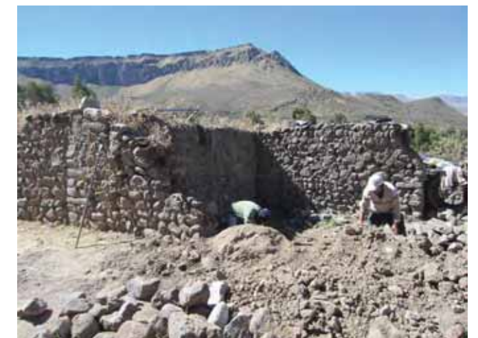
Avance de obra
