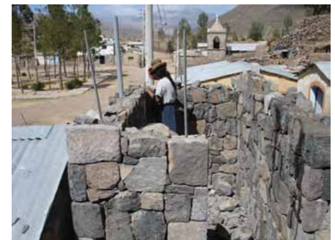
Avance de obra
