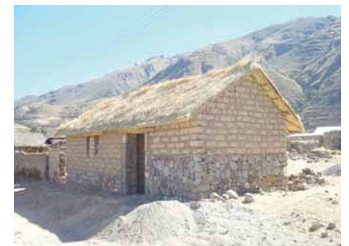
Avance de obra
