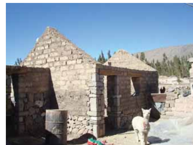
Avance de obra
