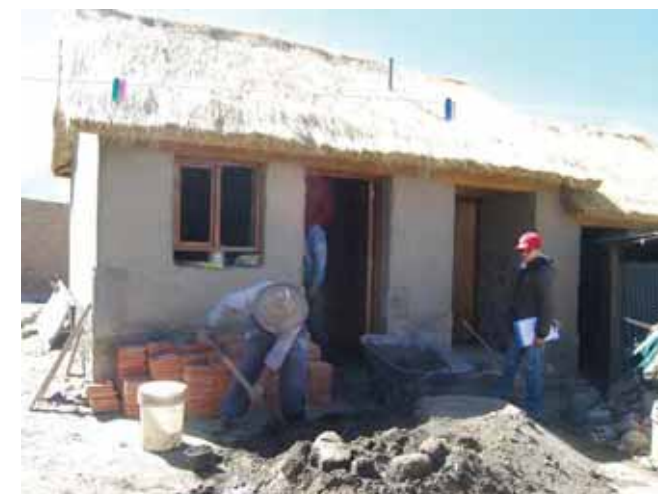
Avance de obra
