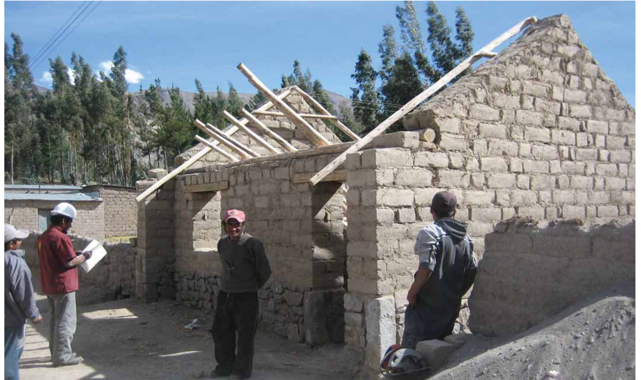
Avance de obra
