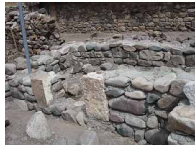
Avance de obra
