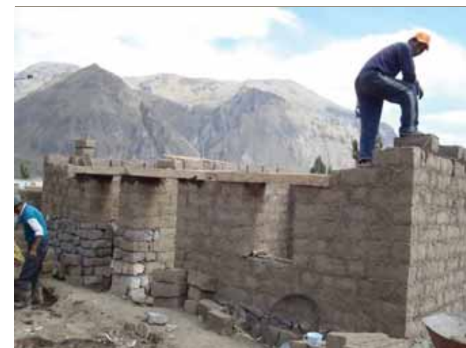
Avance de obra
