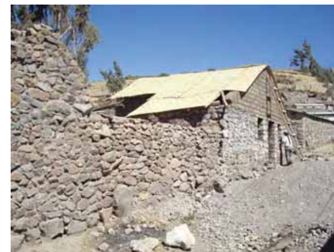
Avance de obra
