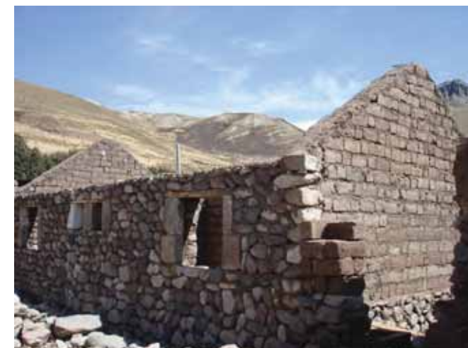
Avance de obra
