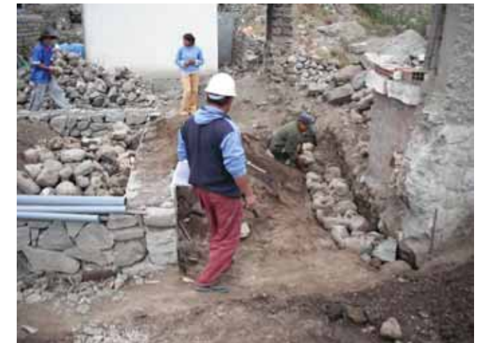
Avance de obra
