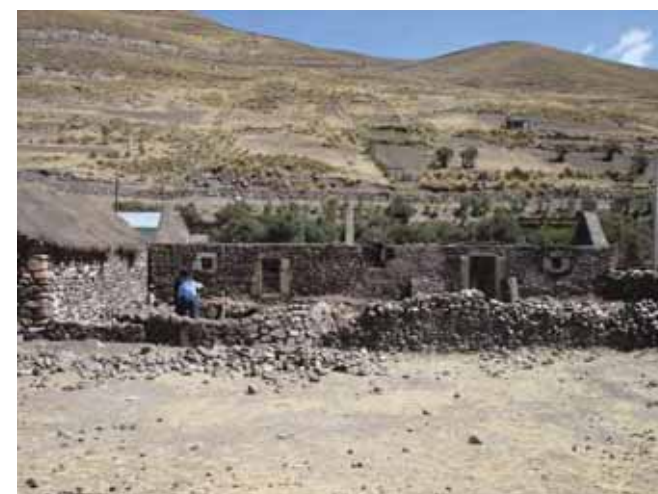
Avance de obra
