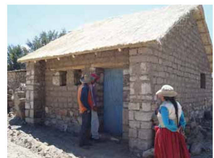
Avance de obra
