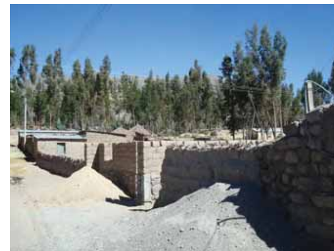
Avance de obra
