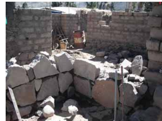
Avance de obra
