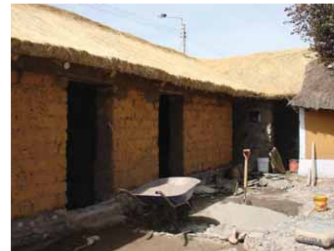
Avance de obra
