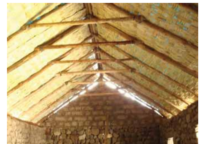
Detalle de cobertura
