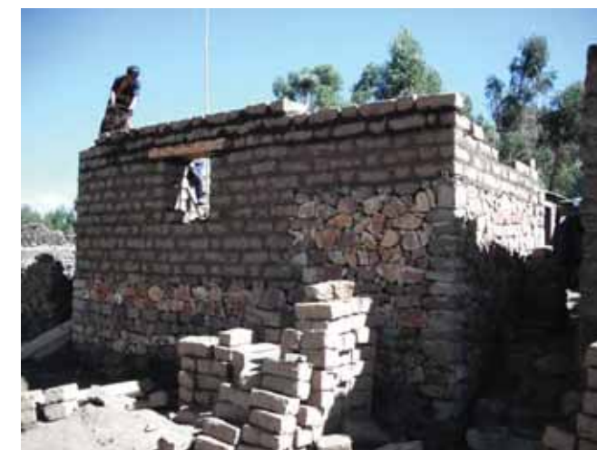
Avance de obra
