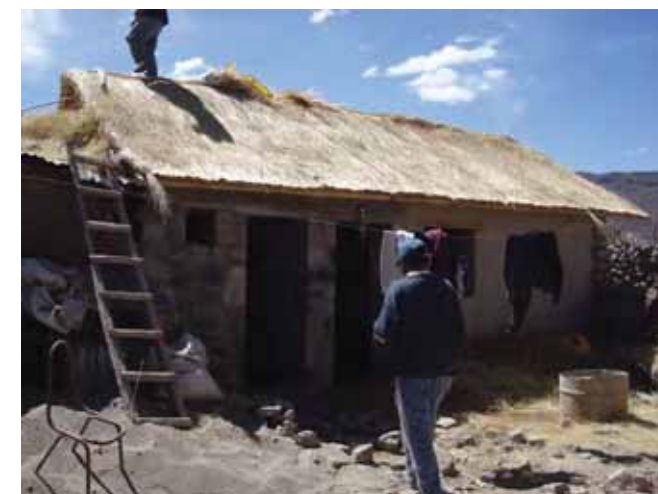
Avance de obra
