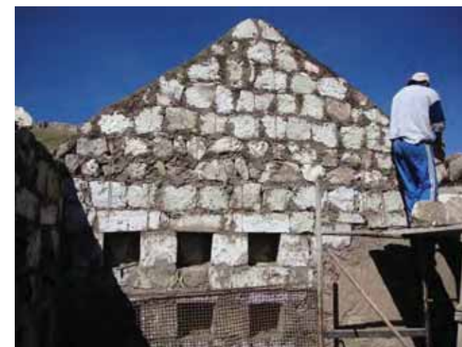
Avance de obra
