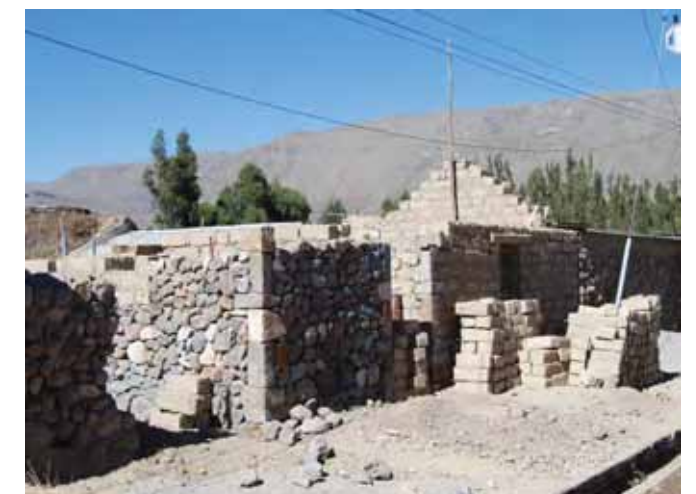
Avance de obra
