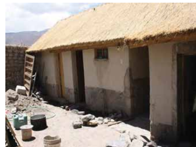
Avance de obra
