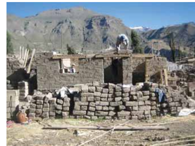
Avance de obra
