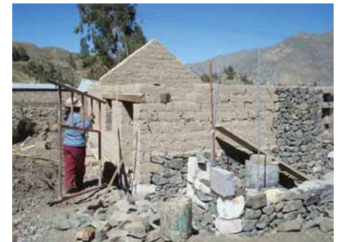
Avance de obra
