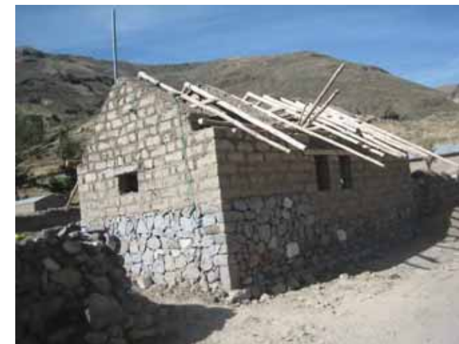
Avance de obra
