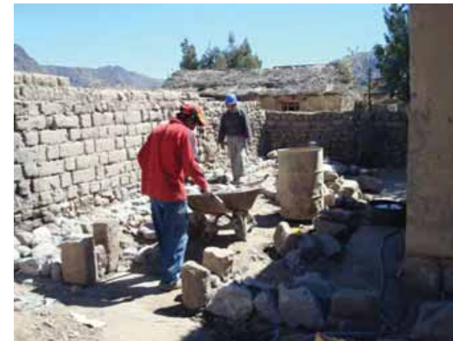
Avance de obra
