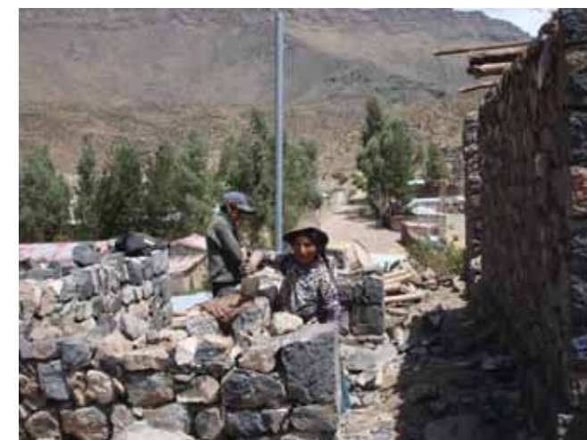
Avance de obra
