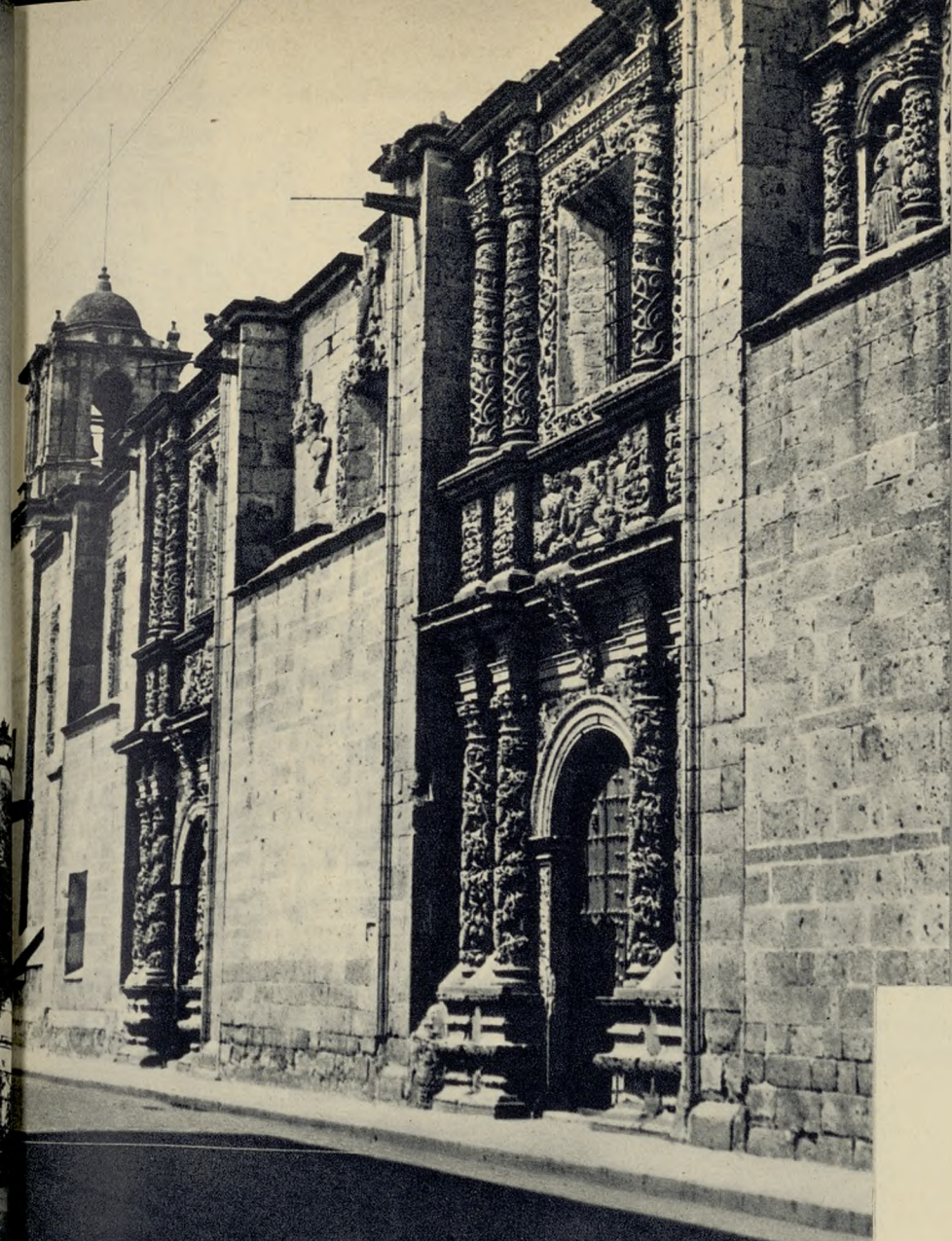
Fachada de la iglesia de Santa Mónica.
