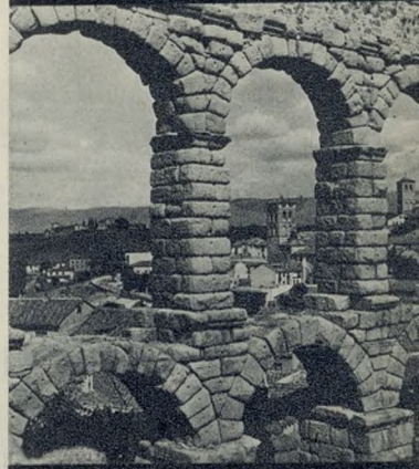
Segovia, a través del acueducto.
