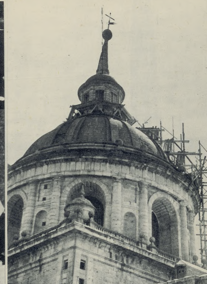
↑ CORRIENDO PARA EVITAR EL PELIGRO.—Todavía no han llegado a la cúspide los obreros que salvaron la basílica del peligro que sobre ella se cernía.—Y desde abajo, el teleobjetivo de la cámara ha registrado con exactitud la peligrosa inclinación de la aguja, que en el grabado se demuestra por la línea trazada sobre la vertical.—La flecha señala el tamaño de un hombre para imaginar el de la cúpula.
