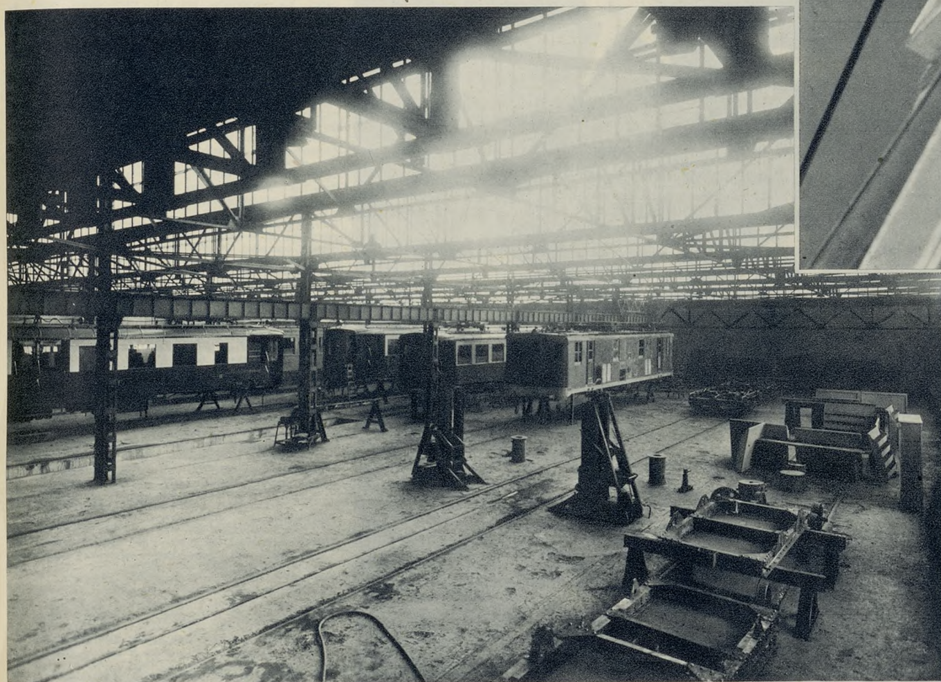
Aspecto parcial del taller de coches de la factoría ferroviaria de Sestao (Vizcaya).
