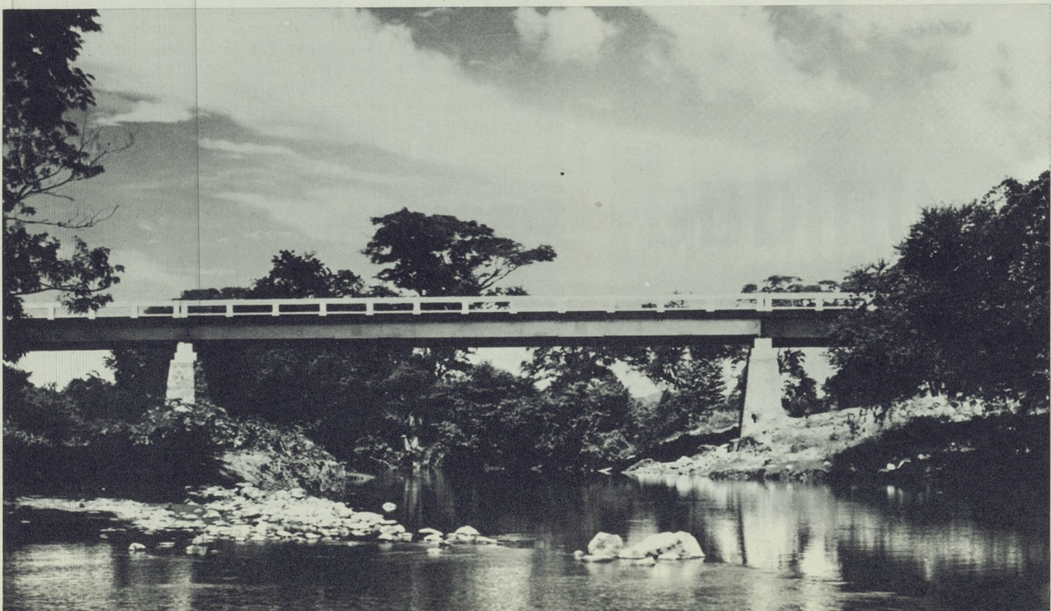
Puente La Leona, de la carretera panamericana, en Honduras
