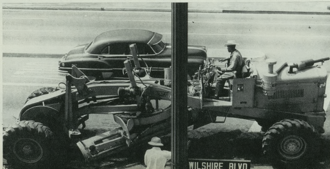
Máquinas especiales reparan inmediatamente los socavones.
