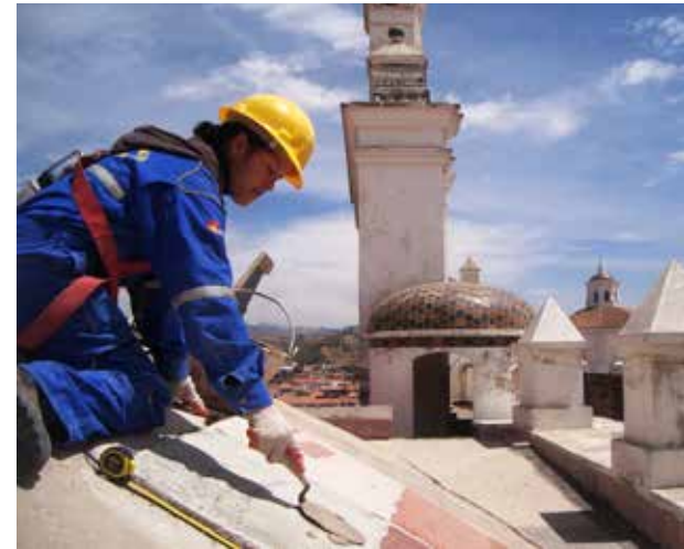
▲ Iglesia de la Merced. Taller de albañilería ◀ Taller de electricidad
