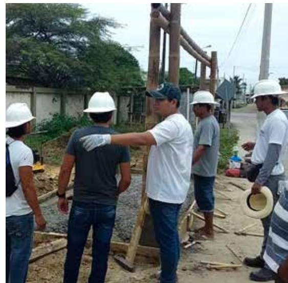
▲ Parada de autobús. Taller de construcción en bambú ▼ Taller de electricidad ▼ Foto alumnos ET
