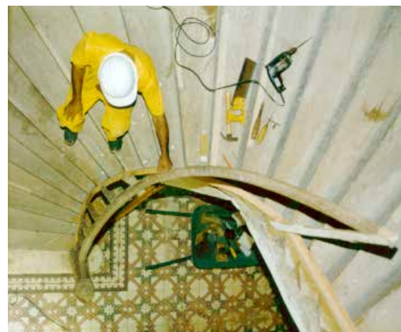
▲ Restauración de balaustrada. Taller de carpintería ◀ Taller de pintura y acabados
