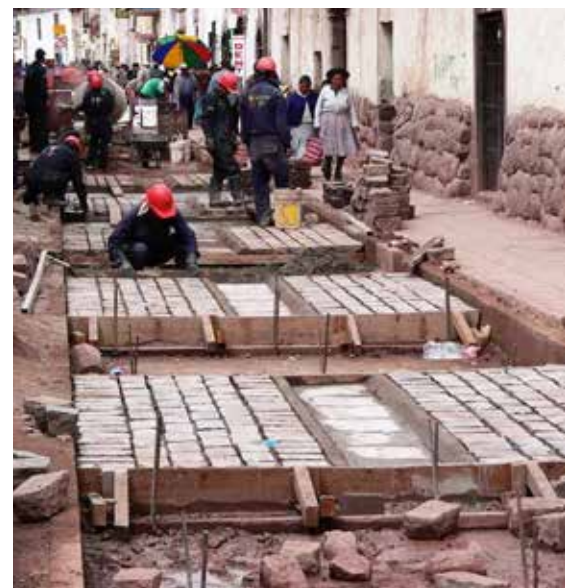
▲ Calle Hospital. Talleres de albañilería y cantería ▼ Taller de carpintería
