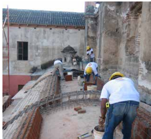
▲ Compañía de Jesús. Construcción de bóveda norte ◀ Aldeas de Antigua. Mantenimiento de parques
