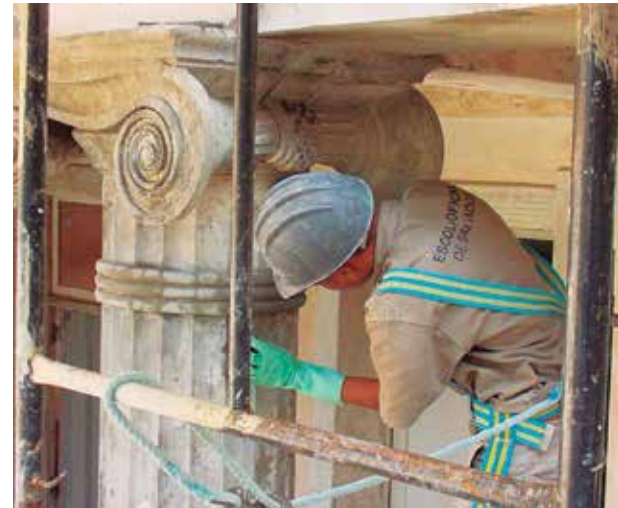
▲ Biblioteca Gonçalo Muniz. Práctica de estuco ◀ Galería Cañizares. Taller de carpintería
