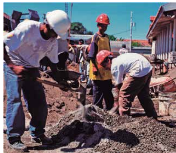
Edificio Ex Comando. Taller de albañilería Taller de herrería
