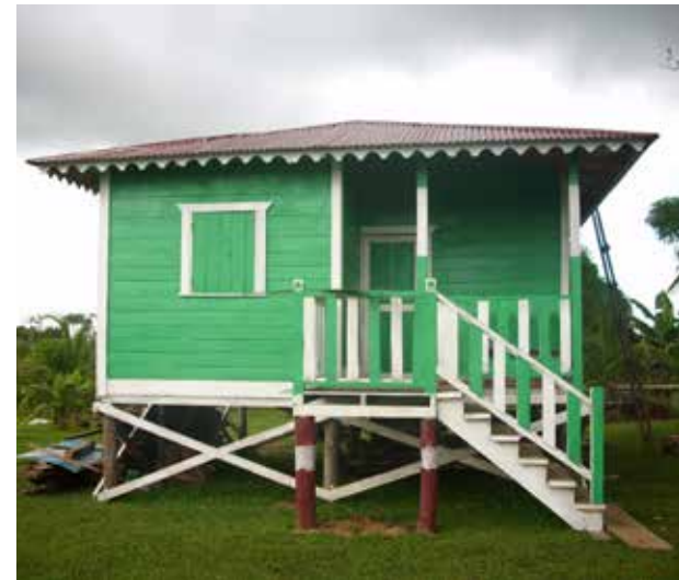
Reconstrucción de Vivienda en Tuara Proceso Finalizada
