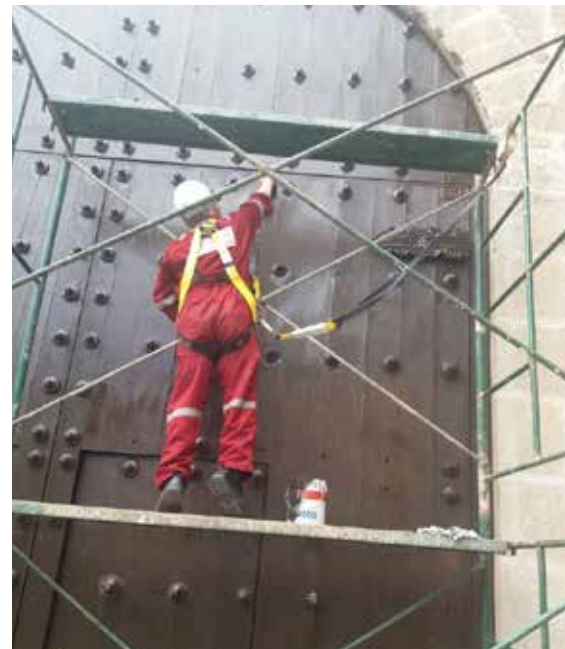
▲ Iglesia San Francisco. Taller de carpintería ◄ Cuarto del Rescate. Labores de mantenimiento
