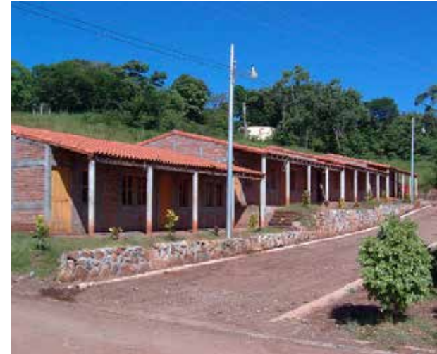
Complejo Ciudad España. Viviendas construidas Modelo I Modelo II
