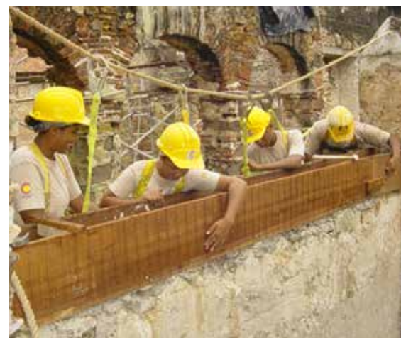
▲ Convento de Santo Domingo. Taller de albañilería ▼ Taller de carpintería
