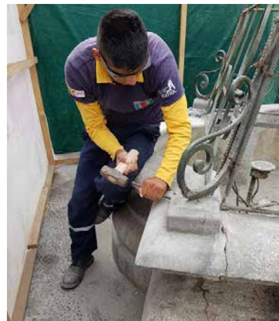
▲ Plaza San Lázaro. Taller de albañilería-cantería ▼ Plaza Quinta de Presa. Taller de carpintería
