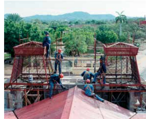
Antigua Estación de Granada Taller de herrería Taller de albañilería
