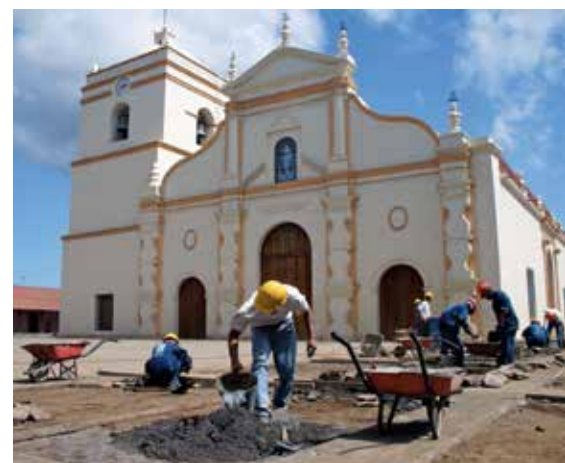
▲ Parroquia La Asunción. Taller de albañilería ▼ Taller de electricidad
