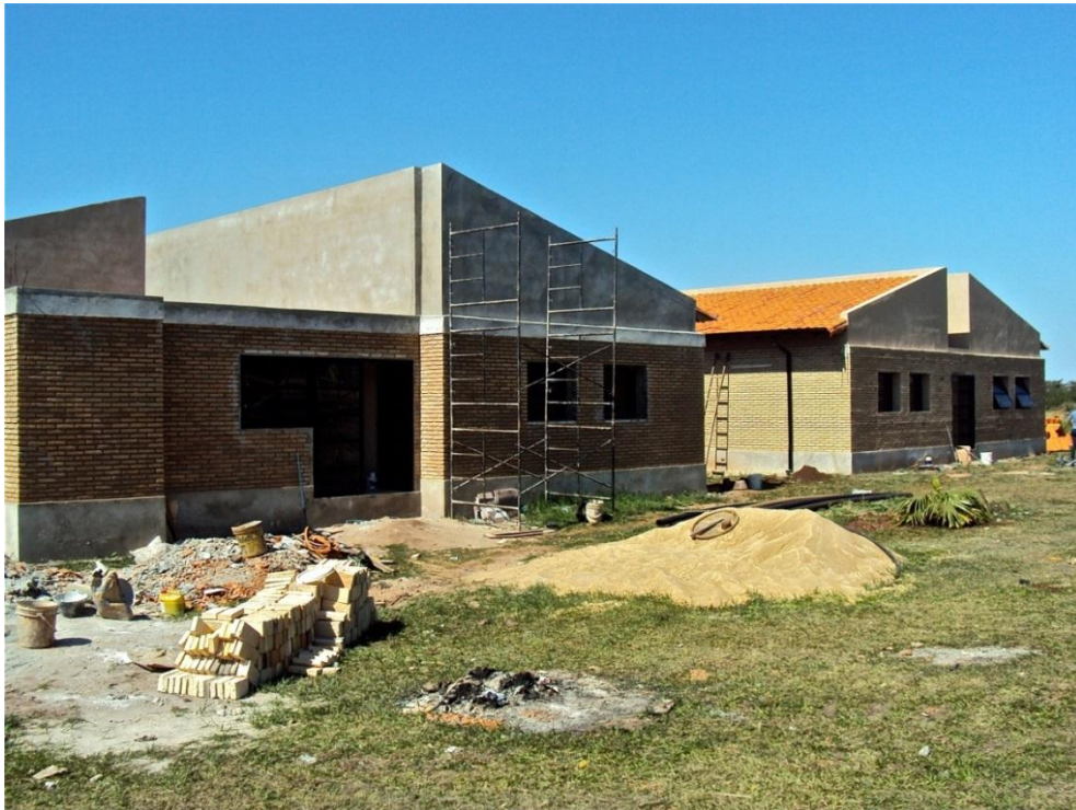
FOTO 6 - Obras Saltos del Guaira- Canindeyú, 2011
