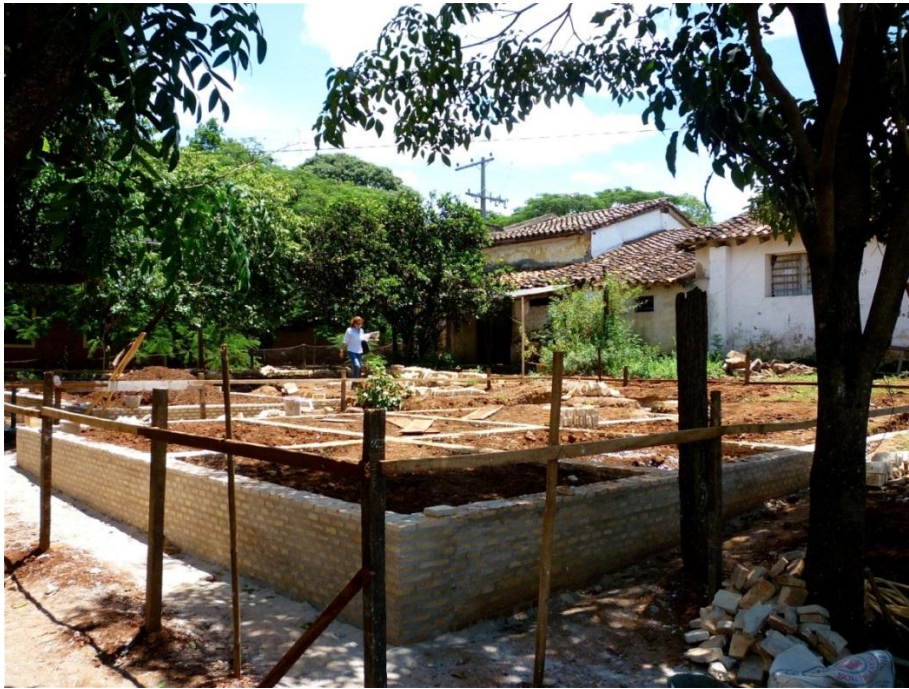
FOTO 10 - Villarrica obras iniciales
