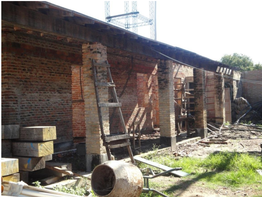
FOTO 8 - Concepción. Ampliación de infraestructura. 2102
