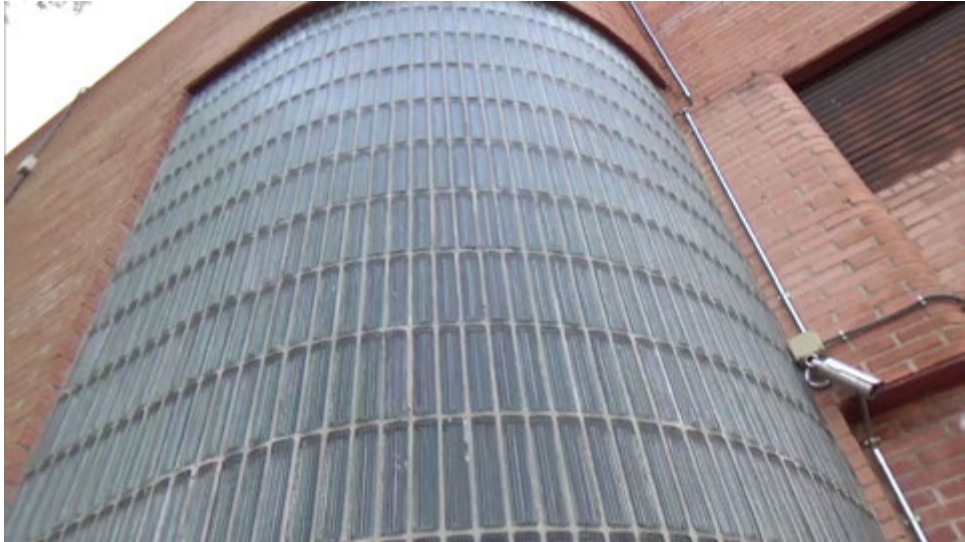
Biblioteca. Celosía exterior
