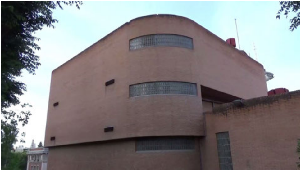
Biblioteca. Vista de celosías desde el exterior
