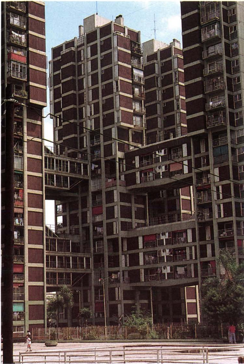
Conjunto Ríoja, Estudio Manteola y otros, 1969. Ejemplo de urbanizaciones construidas según planes nacionales para la vivienda
