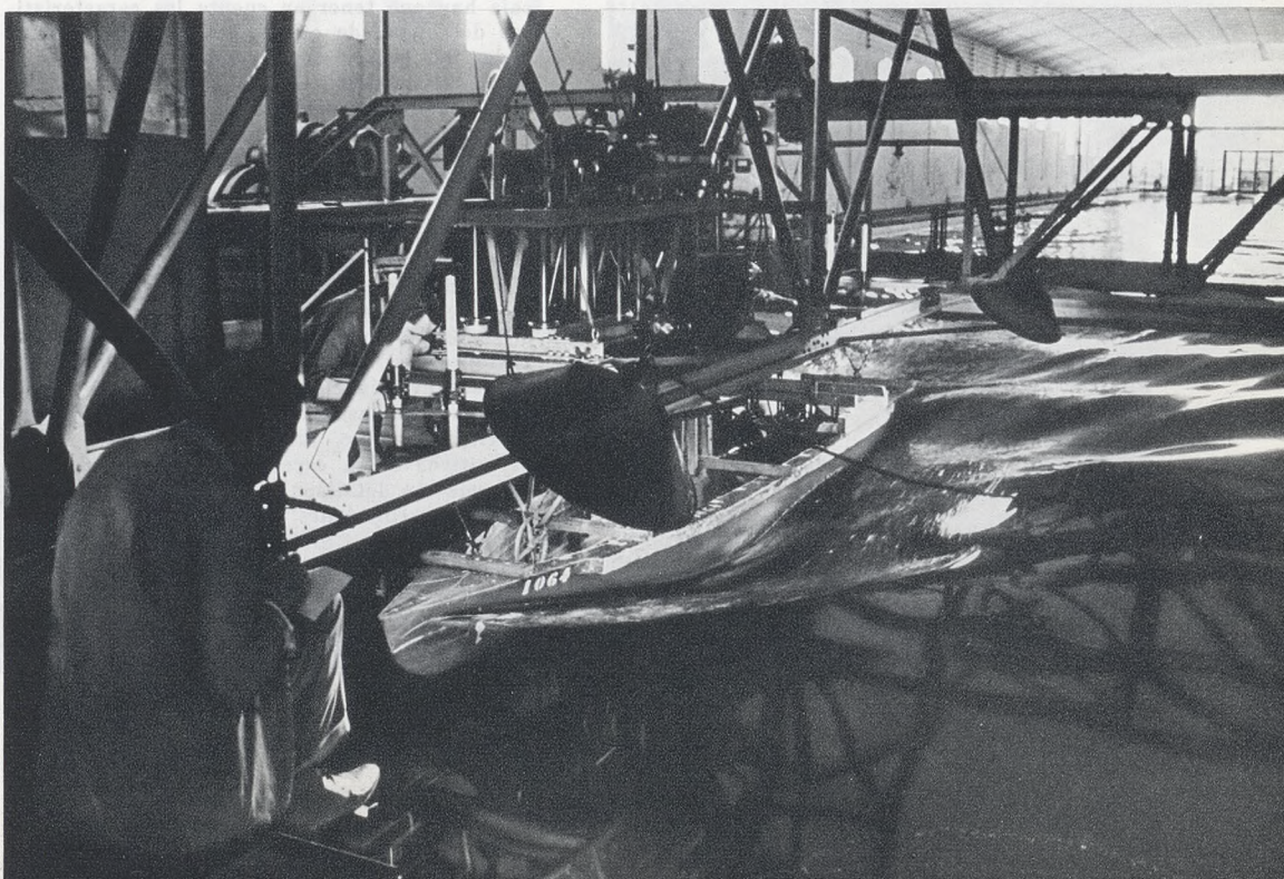
Modelo de buque pesquero en pleno ensayo de autopropulsión.
