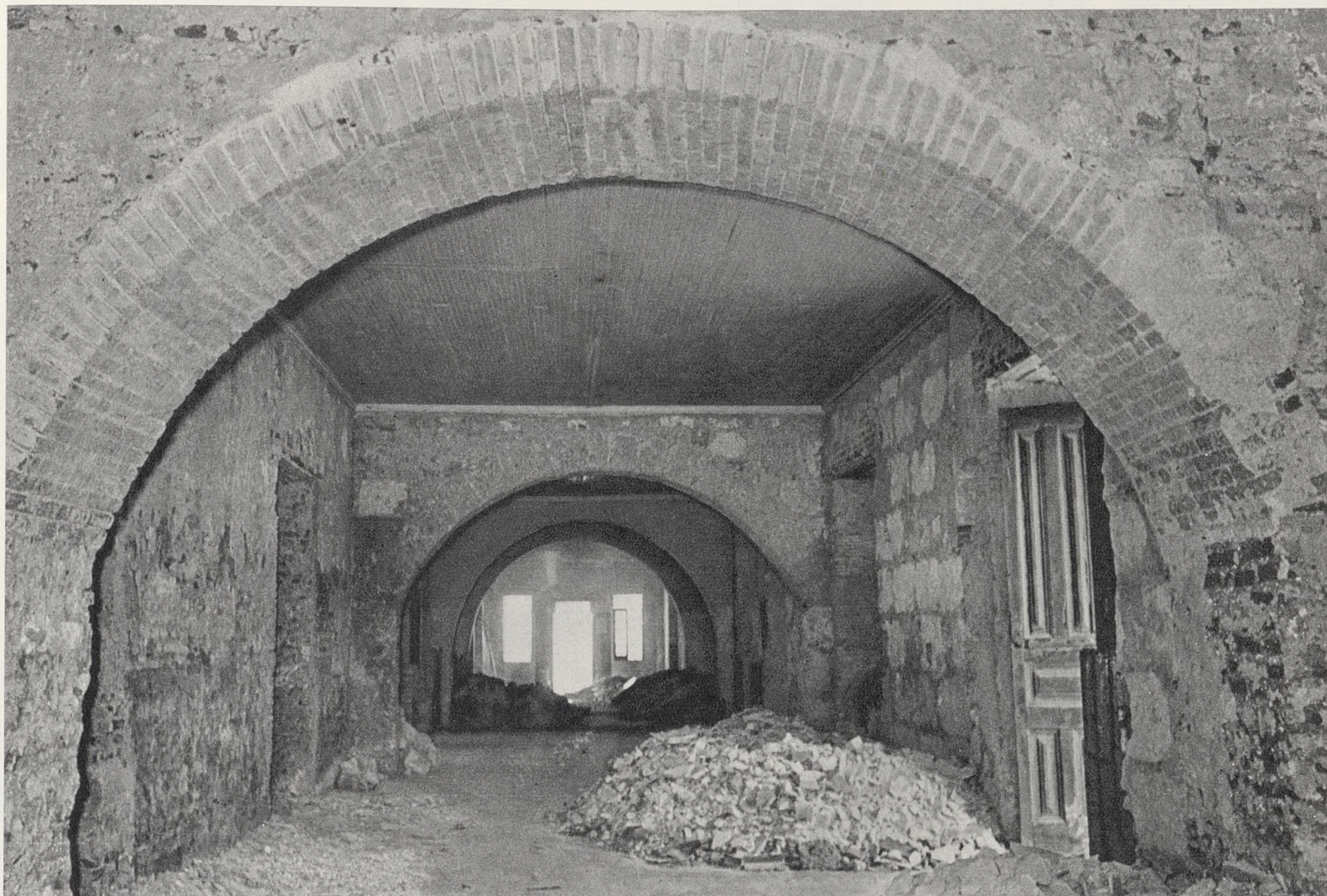
Arriba, a la izquierda, un fragmento del motivo ornamental de la balastrada; a la derecha, la antigua Residencia de los Jesuitas, restaurada para albergar la biblioteca, el archivo, y las oficinas del Museo. Debajo, arcos aparecidos en la cruzía de la primera planta del Palacio de Gobierno.
