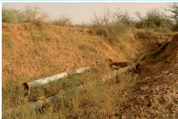
PHOTO 14: Installations pour l'aménagement des périmètres maraichers CR Dodel (Podor/Saint Louis)
