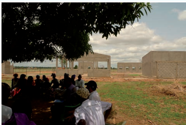
PHOTO 5: Visite au centre d'étuvage de riz GPF Soutouré (Velingara/Kolda)
