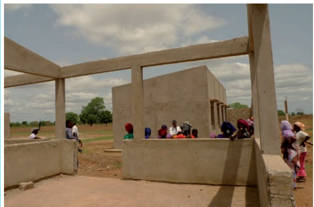
PHOTO 4: Visite au centre d'étuvage de riz GPF Soutouré (Velingara/Kolda)
