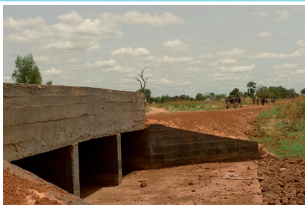
PHOTO 8: Construction piste et dallot GIC Vélingara (Kolda)
