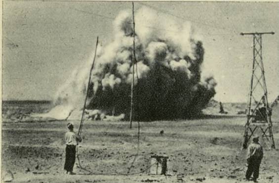
Explosión para remover «caliché».
