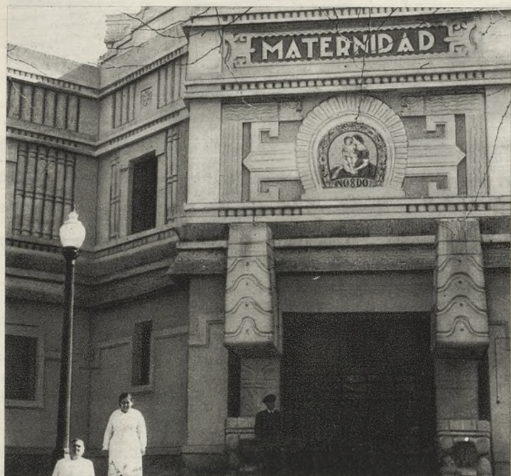
Pabellón de Colombia en la Exposición Iberoamericana, hoy dedicado a Casa de Maternidad de Sevilla. Los edificios que alzaron las repúblicas americanas, una vez cedidos a España, están aplicados a fines sociales.
