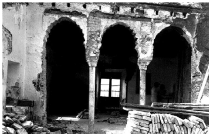
Imagen Nº 17 Estado de las obras en 1935. Fuente Legado Temboury . ( Fotografía Buzo )
