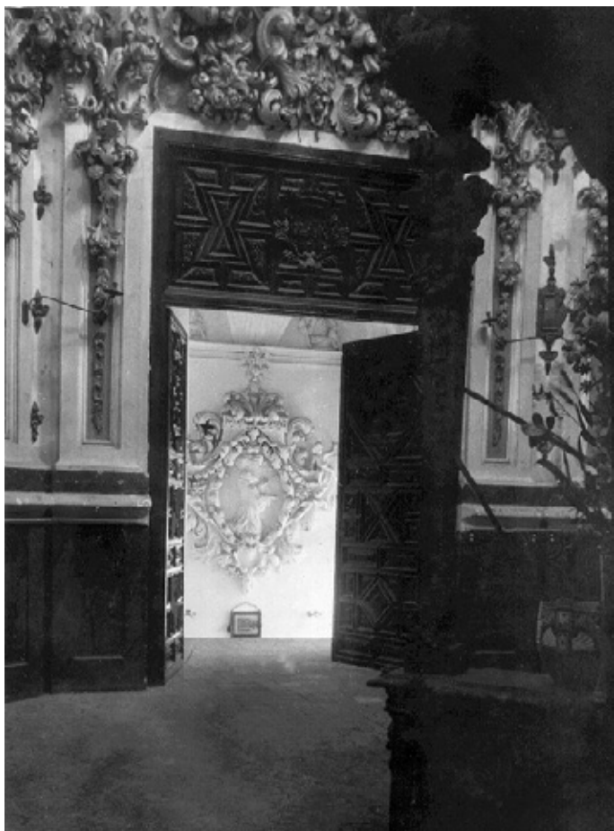
Imagen Nº 40 Entrada al camarín. Fuente: Legado Temboury (Fotografía Temboury)
