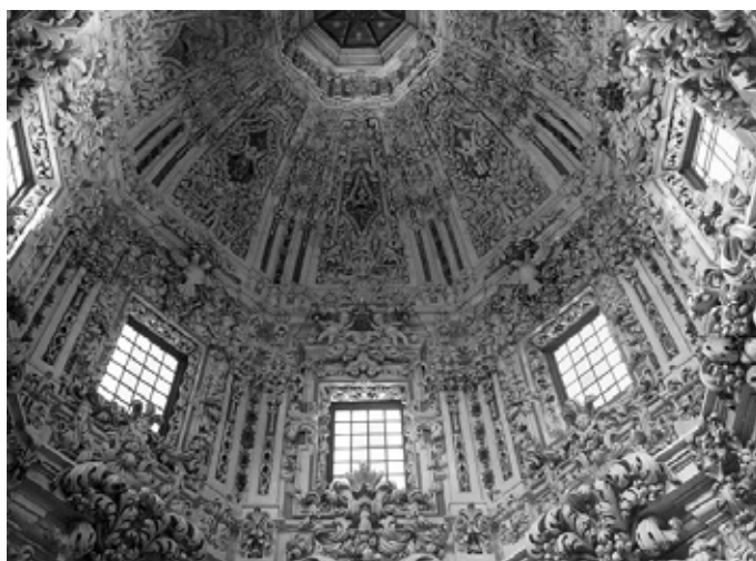
Imagen Nº 41 Cúpula del camarín. Fuente: Legado Temboury (Fotografía Archivo Mas 1946)
