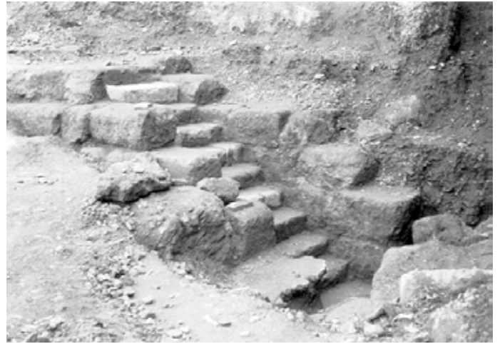
Imagen Nº 21 Estado de las excavaciones en 1960. Fuente: Legado Temboury. (Fotografía Eduardo Ortega)
