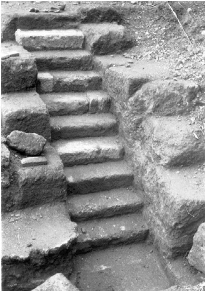
Imagen Nº 22 Estado de las excavaciones en 1960. Fuente: Legado Temboury. (Fotografía Eduardo Ortega)
