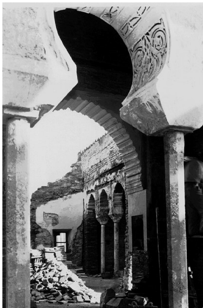
Imagen Nº 18 Aparición en 1935 de la triple arcada original que se encontraba oculta por muros . Fuente Legado Temboury . ( Fotografía Torres Balbás )
