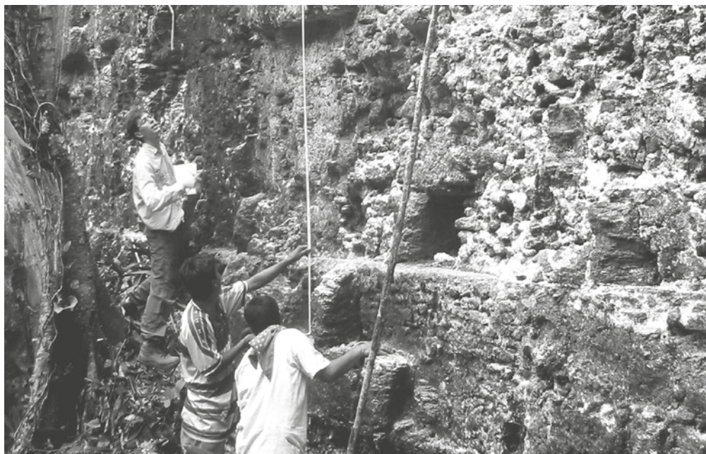
Primeros trabajos en La Blanca
