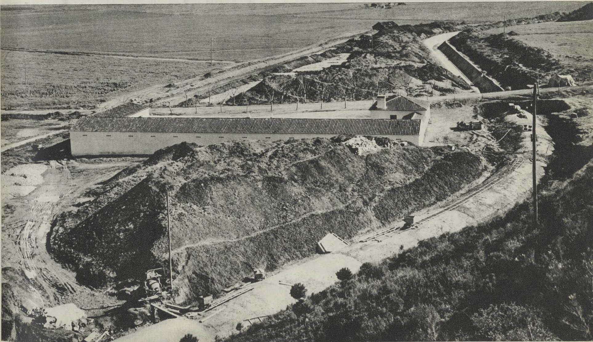
Una vista de la parte en construcción del canal de Lobón. Para protegerlo en todo momento de los posibles arrastres de las laderas, aparte de efectuarse en éstas la repoblación forestal adecuada, se cubre el canal convenientemente.
