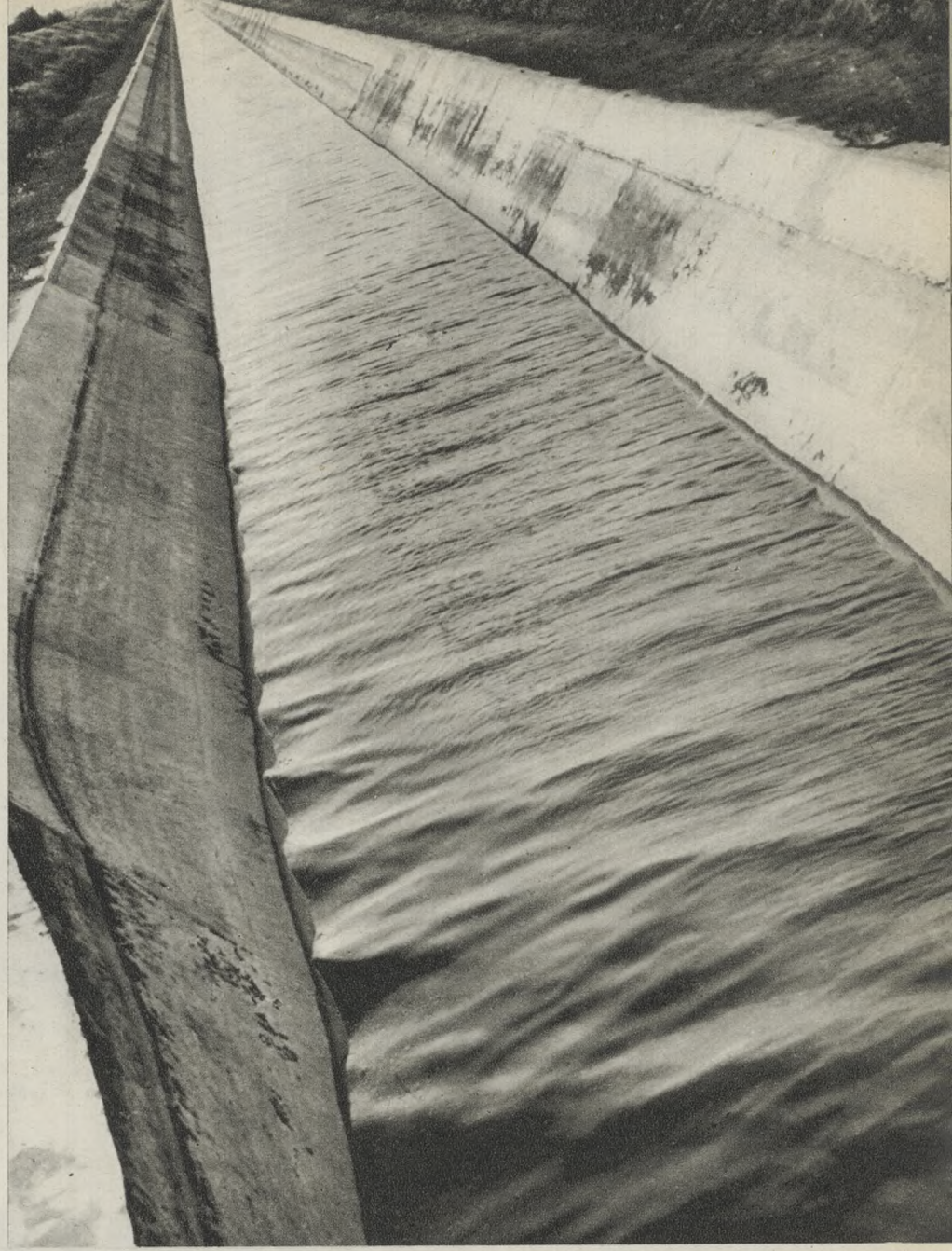
El canal de Lobón parte de la margen izquierda de la presa de Montijo, cuyo túnel vertedero constituye un primer tramo cubierto del propio canal. Tiene 54 kilómetros de longitud, 18 de ellos totalmente construidos y en explotación.
