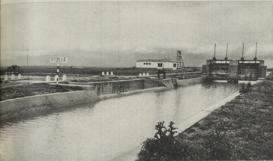
Una vista de la parte en construcción del canal de Lobón. Para protegerlo en todo momento de los posibles arrastres de las laderas, aparte de efectuarse en éstas la repoblación forestal adecuada, se cubre el canal convenientemente.
