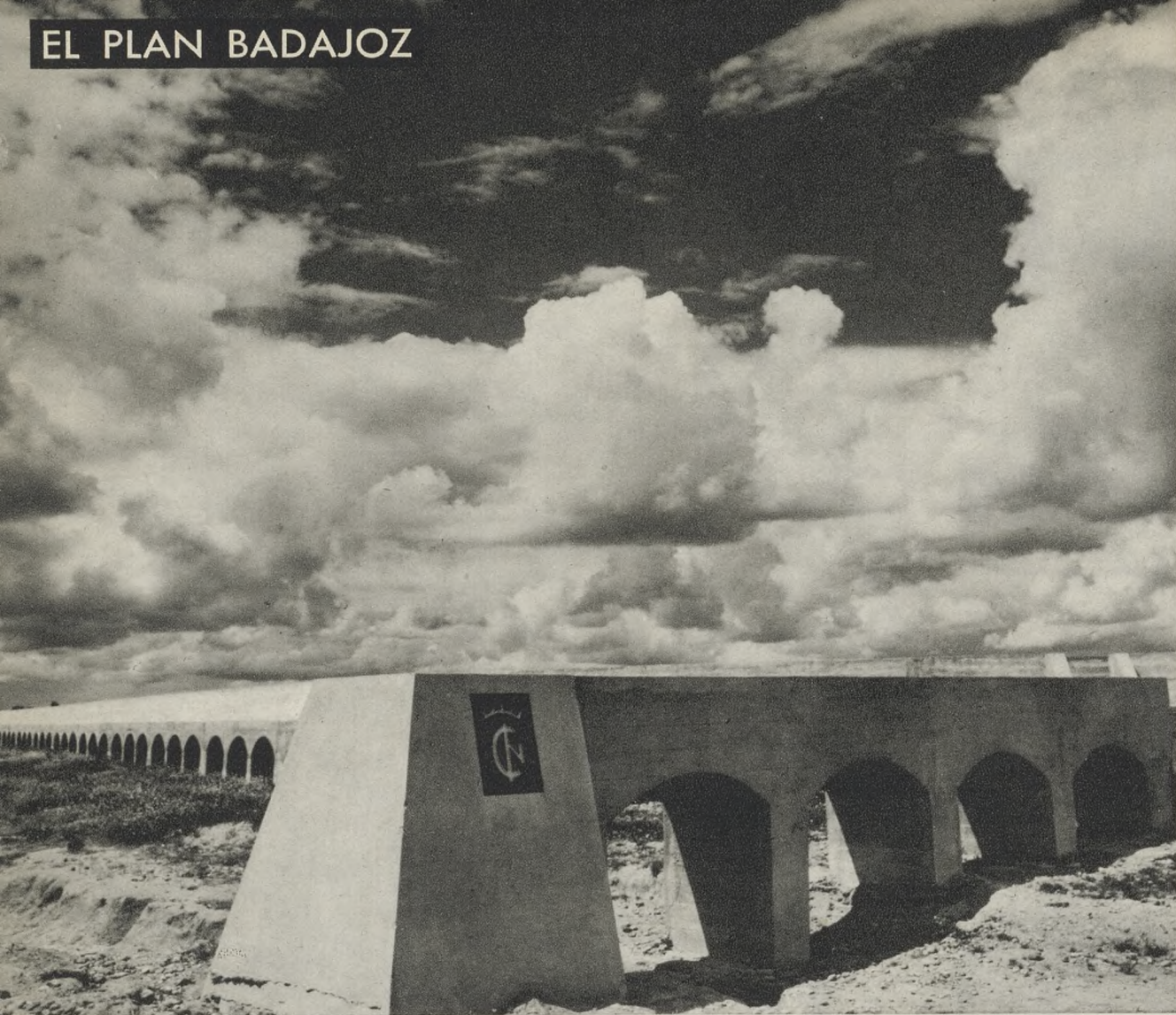
De los canales parten, mediante las oportunas tomas, las acequias principales, y de éstas, a su vez, las secundarias, que se ven en la foto. Además de acequias, se construyen desagües y caminos de servicio.
