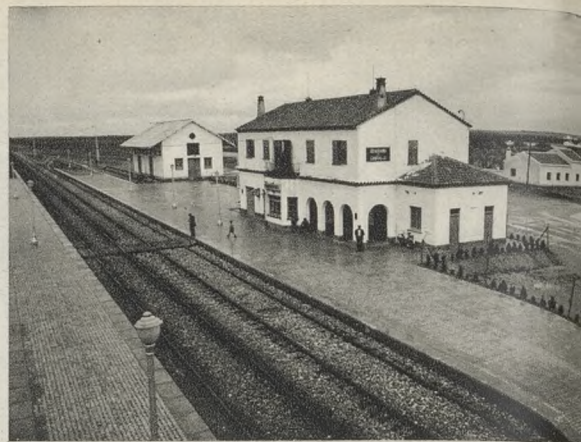
La intensificación de los transportes que los nuevos productos llevan consigo exige la modernización o construcción de carreteras y ferrocarriles. Esta es la nueva estación de Gadiana del Caudillo.
