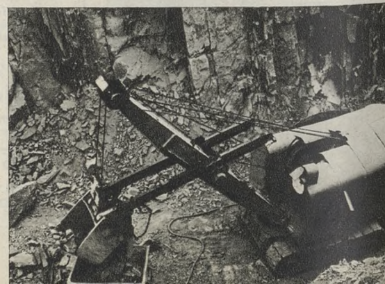
Las palas excavadoras hincan sus dientes metálicos en el terreno, previamente removido por los barrenos, para la construcción del canal de Orellana.
