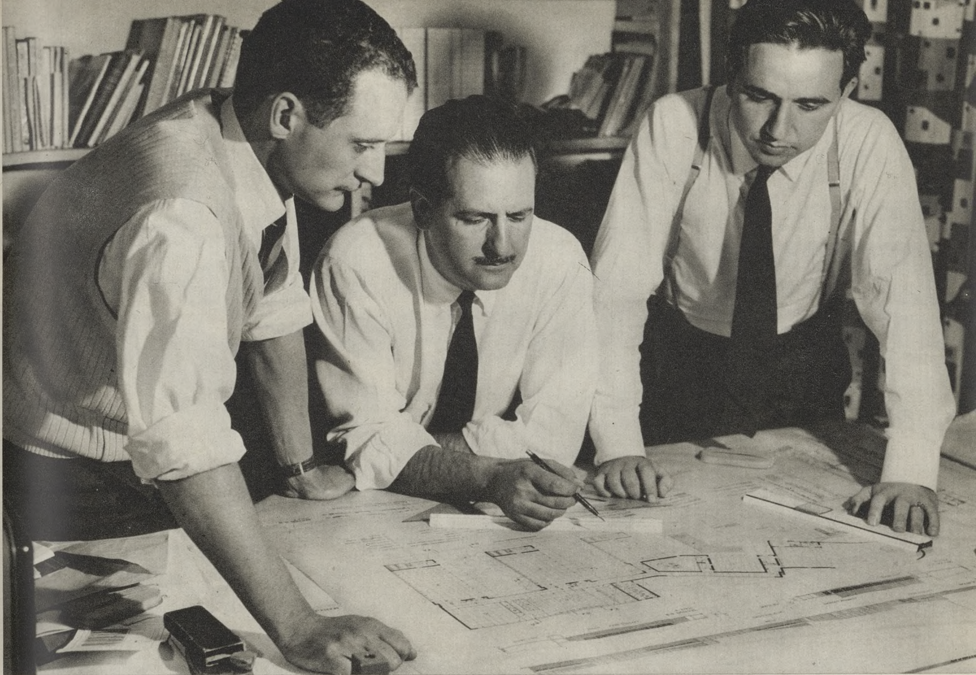
Manuel Barbero Rebolledo, Rafael de la Joya y César Ortiz-Echagüe estudian juntos sus planos. Para los tres arquitectos españoles han sido los 25.000 dólares del «Memorial Reynolds», un premio internacional de alta categoría, por la construcción en aluminio de los comedores de la S. E. A. T. Española, en Barcelona.
