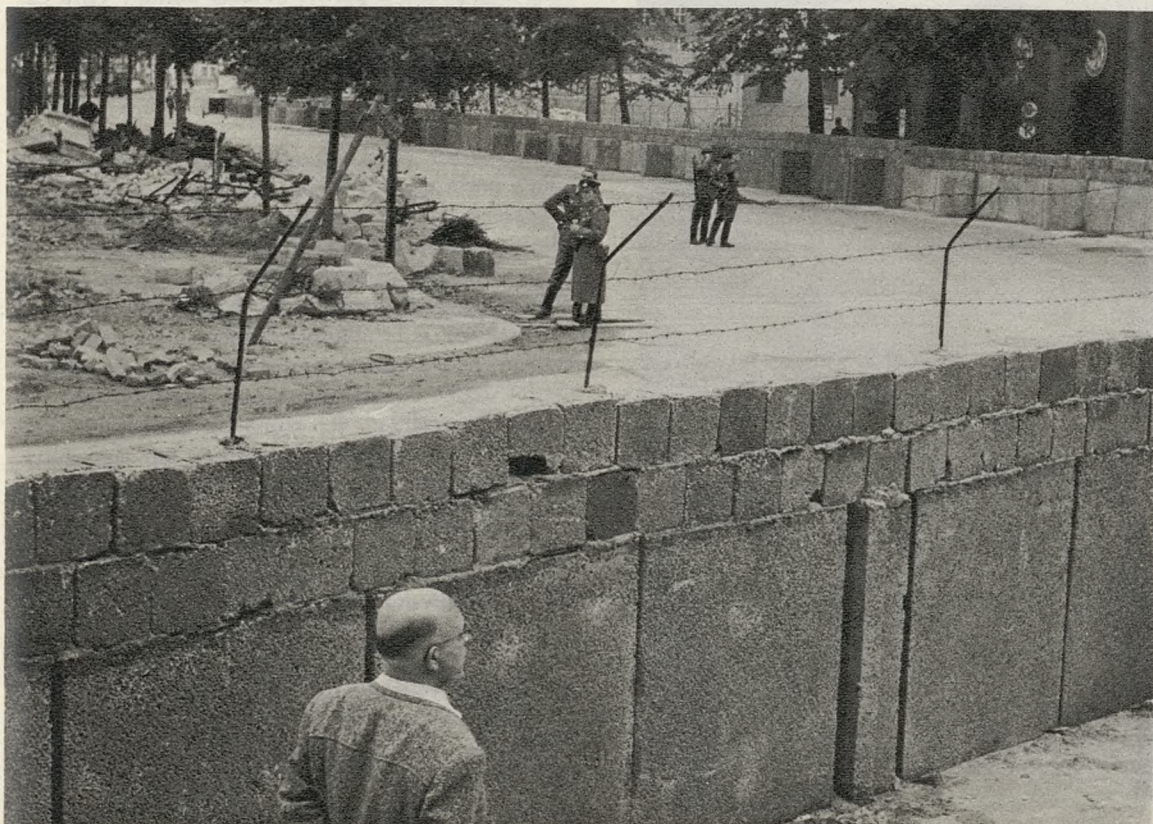
No solamente la ideología sino auténticos muros de cemento separan las dos mitades de la antigua capital alemana
