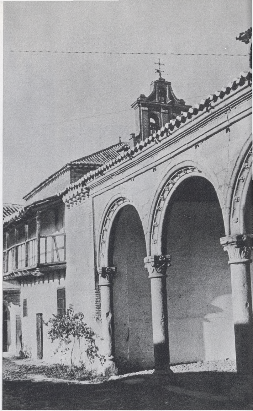
Entrada lateral al palacio-convento.
