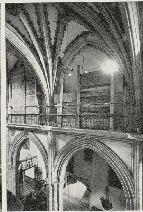
En la página opuesta, perspectiva del claustro principal; para la restauración de ese claustro fueron precisos estudios intensos. En esta página, arriba, vista de las obras en la parte superior de la planta, que corona el monasterio; debajo a la izquierda, camarín con la imagen de Nuestra Señora de Guadalupe, encontrada por el pastor cacereño Gil Cordero, que preside el templo; y a la derecha, otra vista de cómo se encontraba el maravilloso monasterio en la época del abandono.
