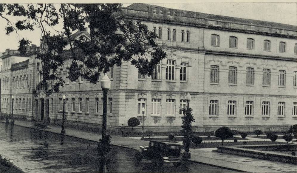
Dos de los más soberbios edificios con que cuenta la arquitectura civil en Galicia son el Instituto de Enseñanza Media y la Delegación de Hacienda de Pontevedra, adorno ambos de una ciudad cuya principal característica es su sin par belleza.
