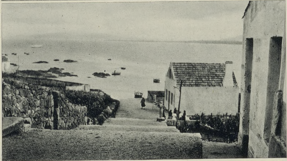
Una escalinata construida por la J. A. M. La primera de las fotografías muestra el estado en que se encontraba la bajada al mar con anterioridad a su reforma, realizada en dicho pueblo.
