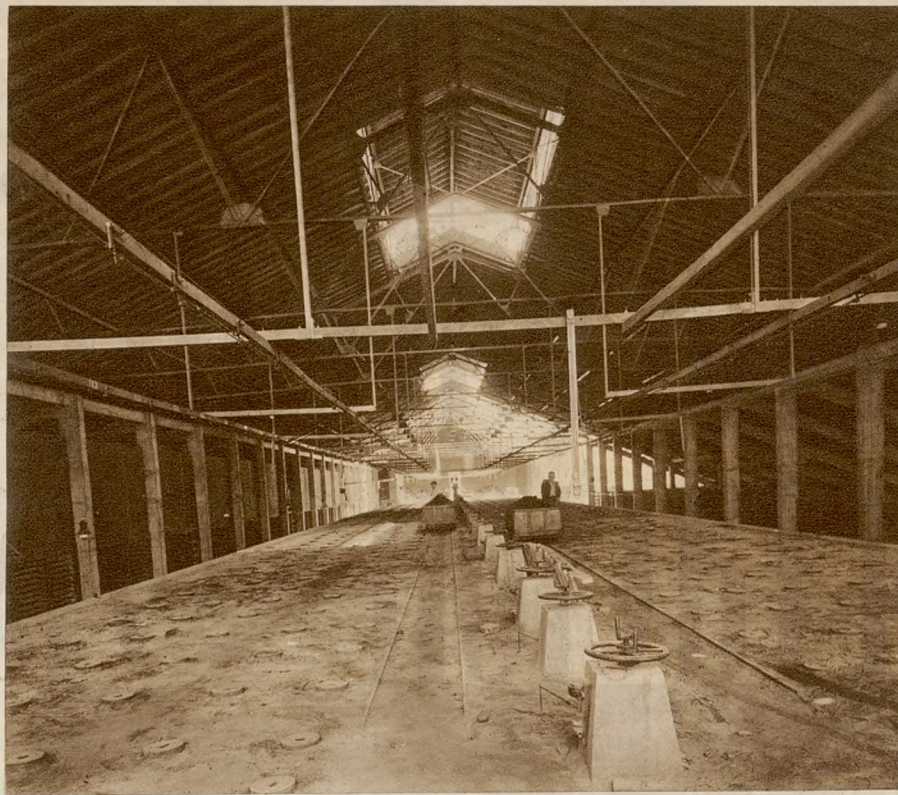
Fábrica de cerámica EL CASTELO, en Monforte de Lemos, especializada en la producción de materiales para la construcción. En la fotografía puede verse la parte superior de uno de los grandes hornos, con sus alimentadores automáticos.
