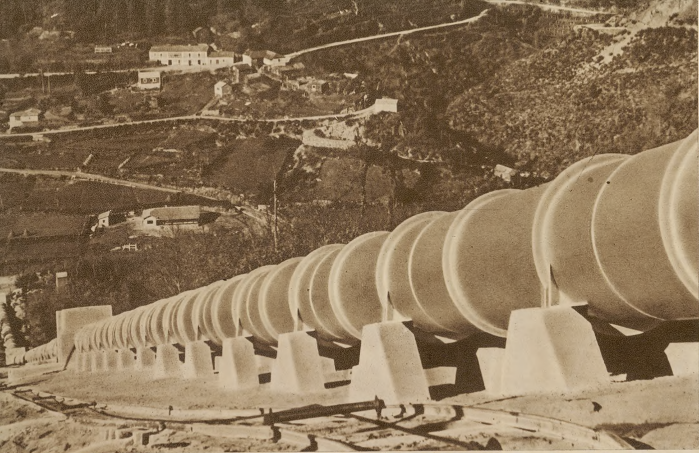
Después de salir del túnel, las aguas del modernísimo salto de Las Conchas descienden por esta tubería espectacular.
