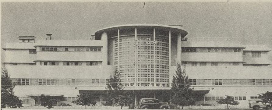
Fachada del edificio Jai-Alai.
