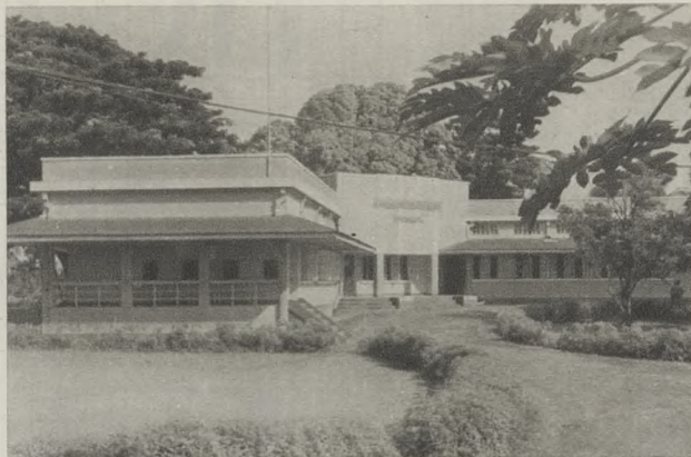
Edificio de la Administración.
