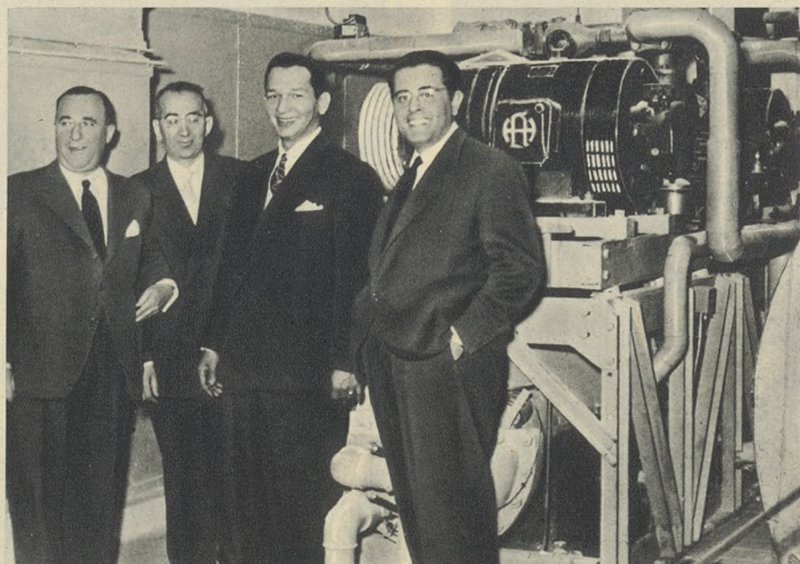
El equipo de AUTOELECTRICIDAD puede sonreír: ya tiene instalado en el Hotel Fénix, "el clima Carrier, primavera todo el año".
