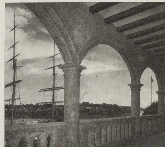
Galerías altas de la fachada este.
