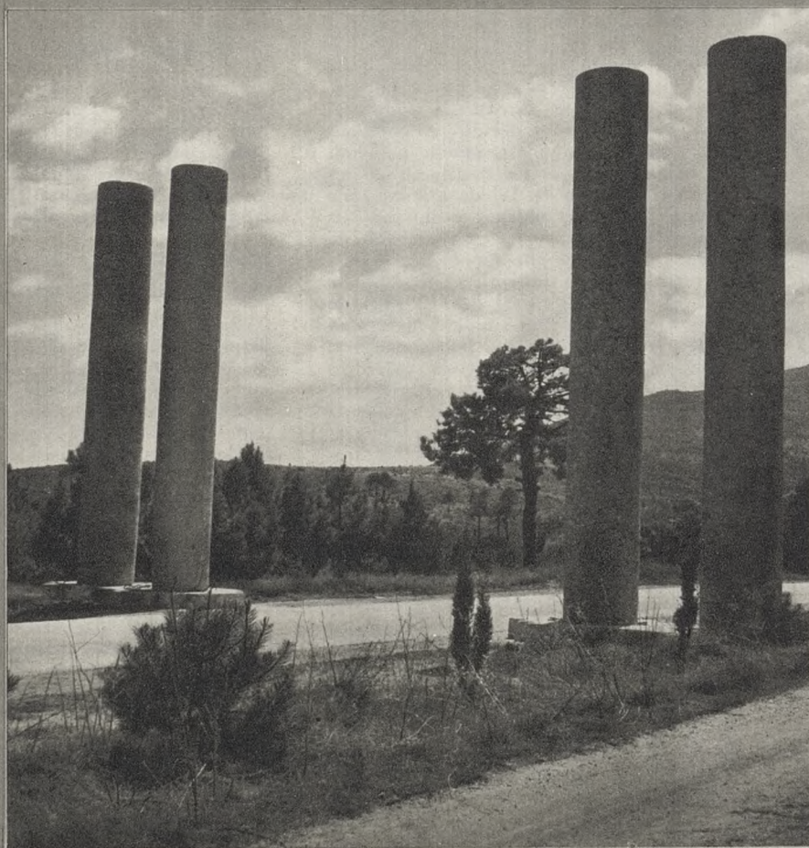
Estas son las célebres columnas que Juanelo dispuso para que sostuvieran un palacio a la orilla del Tajo, en Aranjuez. Hoy dan entrada al Valle de los Caídos.
