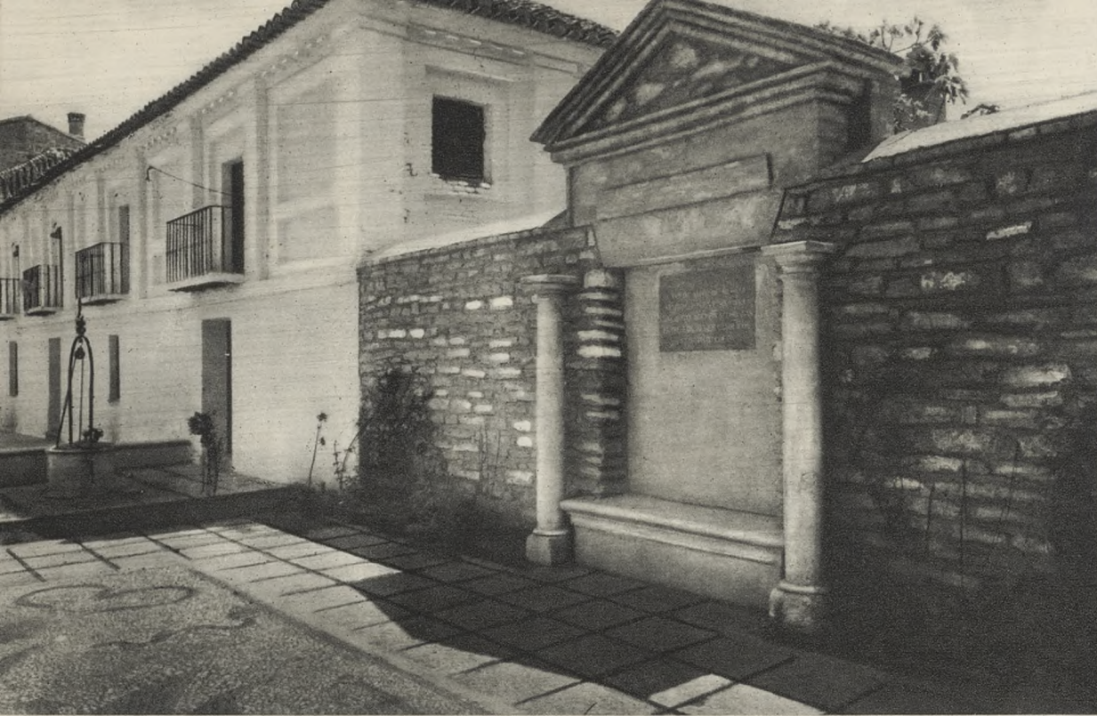
Lugar en que se levantó la Casa Real, en que fueron firmadas las Capitulaciones entre los Reyes Católicos y Colón para el descubrimiento.
