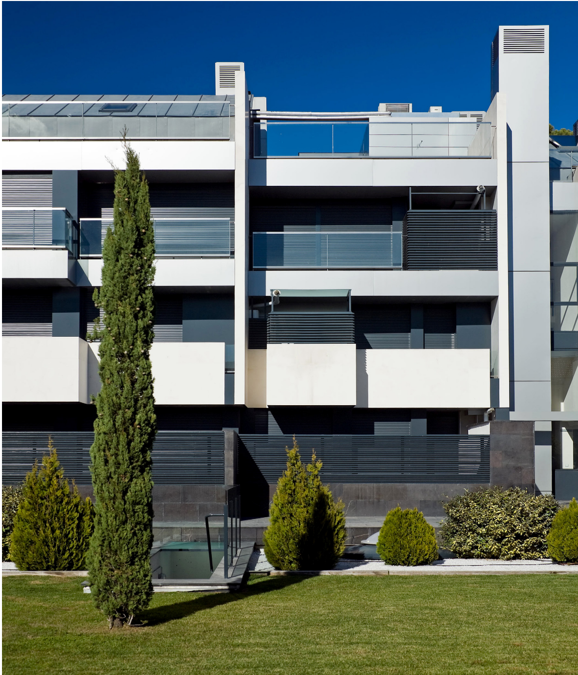
VIVIENDAS Pozuelo., Madrid. Tauzs + Barrio.
