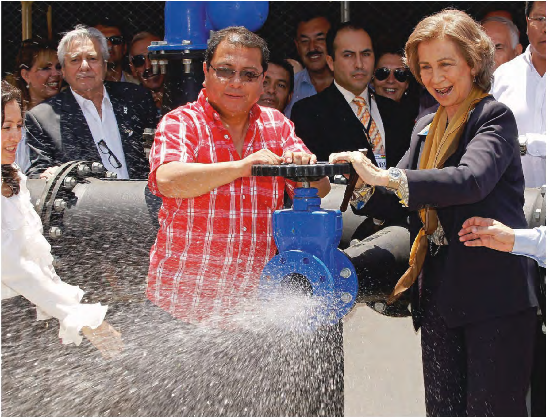
El proyecto de potabilización y alcantarillado, inaugurado por Su Majestad y financiado por la Cooperación Española, es el punto de partida para construir una planta de tratamiento de aguas residuales en la ciudad.
