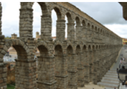
Segovijos akvedukas – vienintelis pilnai išlikęs senovės romėnų civilinės inžinerijos statinys Europoje
