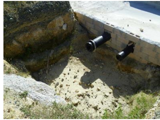
Fotografía 4: Excavación y cama de cimentación del depósito de regulación de Báguanos
