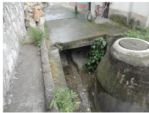
Fotografía 4: Imagen de un pozo de registro del actual sistema de recolección de aguas grises
