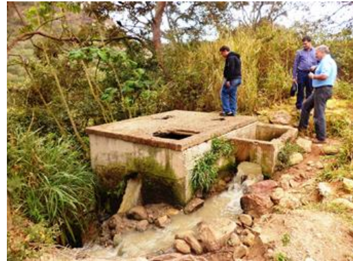
Fotografía 2: Entrega actual del sistema de alcantarillado existente.
