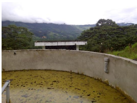
Fotografía 1: Filtro lento de arena en desuso con caseta de cloración en segundo plano sistema San Pedro (Zamora-Chinchipe)
