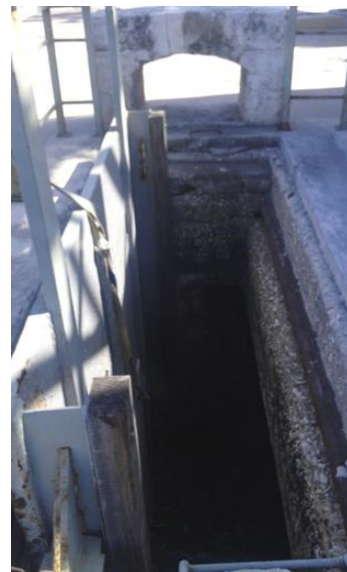
Fotografía 2: Arqueta de entrada de la cámara del Muelle de Caballerías
