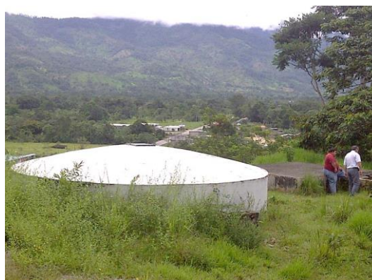
Fotografía 2: Tanque de reserva en desuso (en primer plano), tanque antiguo en uso con agua no tratada en segundo plano. Al fondo la comunidad de Leónidas Proaño (Zamora-Chinchipe)
