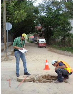
Fotografía 1: Catastro sistema de alcantarillado.
