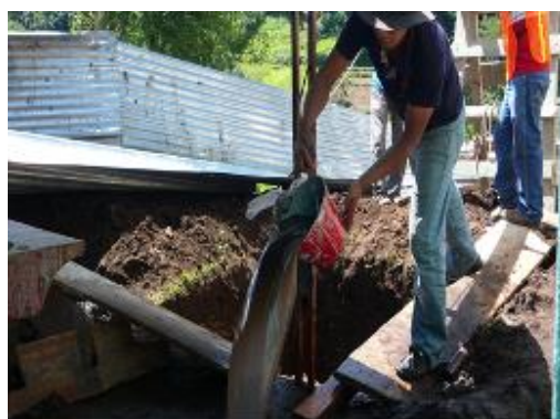
Fotografía 6: Excavación para toma de muestras de suelos. Caserío Santa Rosa. Sololá
