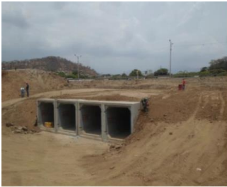
Fotografía 1 Box cover colocado y con Relleno del pasos sub-férreos para comunicar los canales secundarios con el canal principal que evacua al mar.
