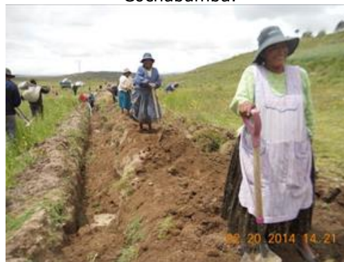
Fotografía 4: Comunarios trabajando en la construcción de la red de aguas en Icrana, La Paz.
