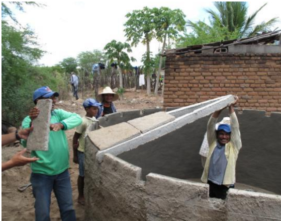
Proceso de construcción de una cisterna
