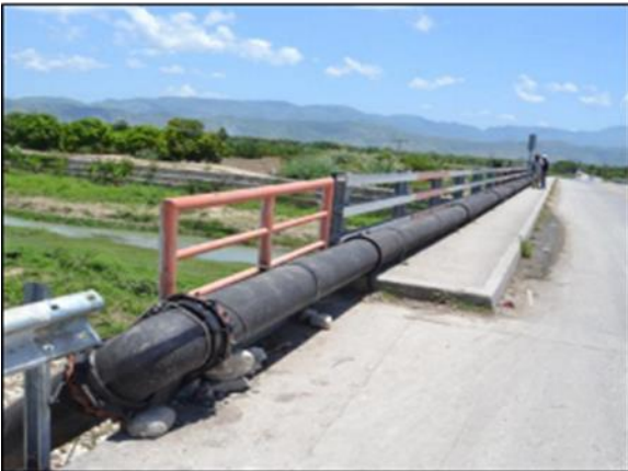
Fotos 3-4.- Línea de impulsión y estación de bombeo rehabilitadas en Gonaïves (Trabajos de urgencia)
