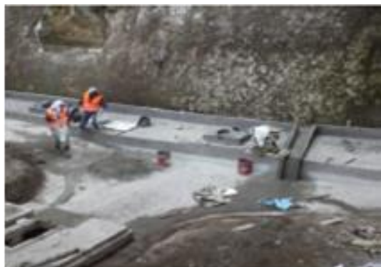
Fotografía 1: Construcción de sistema de agua Comunitad Xequistel
