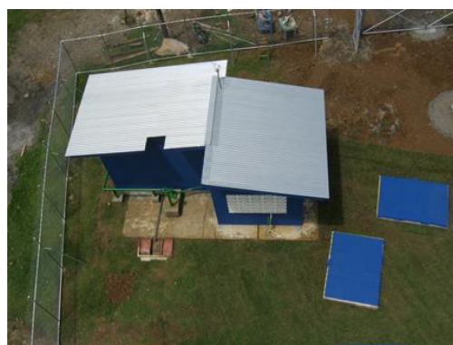
Fotografía 4: Vista de la caseta de bombeo desde tanque elevado. Acueducto Palmitas II. 10 de octubre 2014
