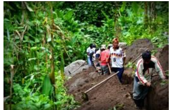
Fotografía 6: Trabajo comunitario para la ejecución del lote 1 de obra.
