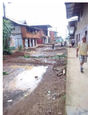
Fotografía 2: Instalación red acueducto en Bahía Solano
