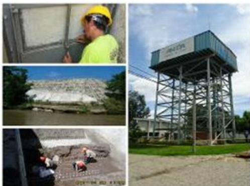
Fotografía 1: Fortalecimiento Institucional: reparación de muro de contención, tanque elevado y compuerta de filtros en Planta potabilizadora Las Pavas.
