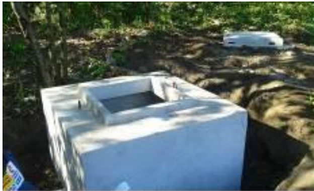
Fotografía 1: Ejecución de Obras, Lote 1.1 Mejoramiento de sistema de abastecimiento de agua San Pedro La Laguna
