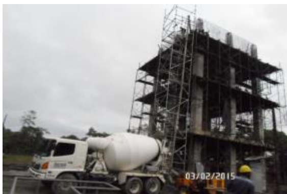
Fotografía 1: Construcción tanque elevado en Acueducto Atrato
