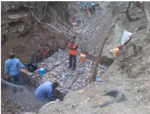
Fotografía 1 Box cover colocado y con Relleno del pasos sub-férreos para comunicar los canales secundarios con el canal principal que evacua al mar.
