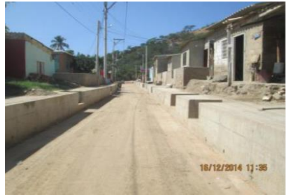
Fotografía 2 Canal secundario concluido
