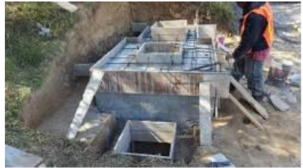
Fotografía 2: Ejecución de obra en proyecto de la Comunidad Guativil.
