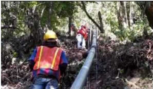
Fotografía 1: Avances en la construcción de la línea de Impulsión. Comunidad Sacuchum
