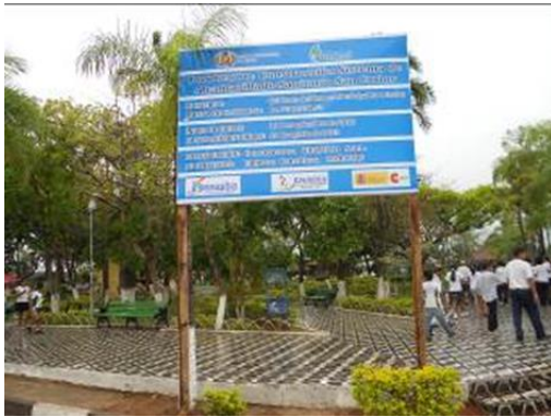
Fotografía 3: Inicio de las obras del Sistema de Alcantarillado sanitario en la localidad de San Carlos
