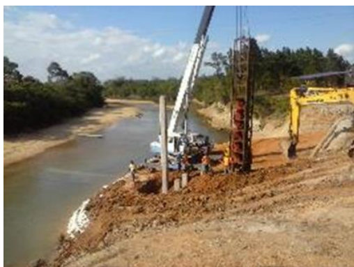
Fotografía 1: UBICACIÓN BOCATOMA de BILWI
