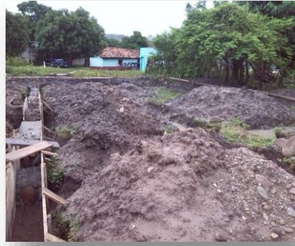
Fotografía 2: Construcción de la futura sede de la Unidad de Agua
