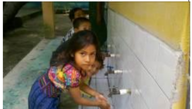
Fotografía 6: Infraestructura Sanitaria para escuelas saludables
