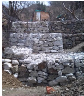
Fotografía 4 Colocación de capas de piedra de la presa anti-erosión
