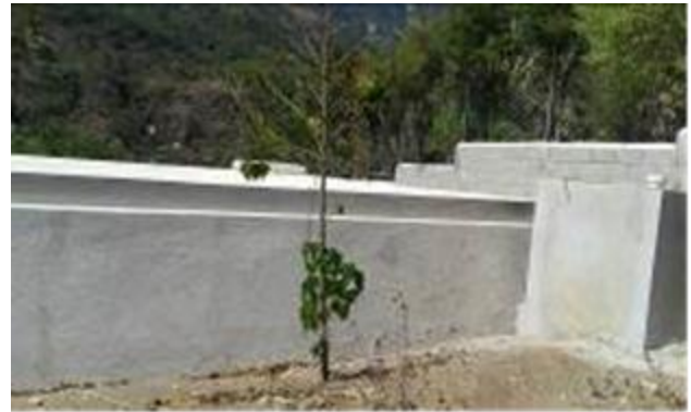
Fotografía 2: Ejecución de Obras, Lote 1.1 Mejoramiento de sistema de abastecimiento de agua San Marcos La Laguna
