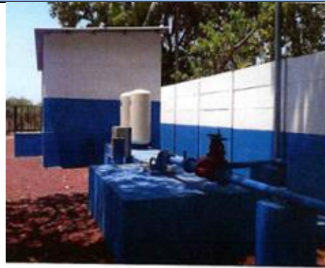
Fotografía 2: Introducción del sistema de agua potable y saneamiento básico en Cantón corral de mulas, municipio de Puerto El Triunfo, Depto. Usulután.
