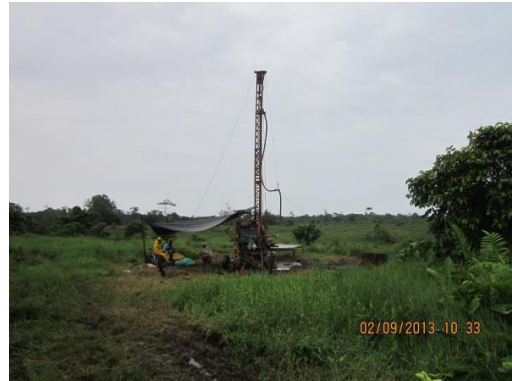
Fotografía 2. Ejecución del pozo
