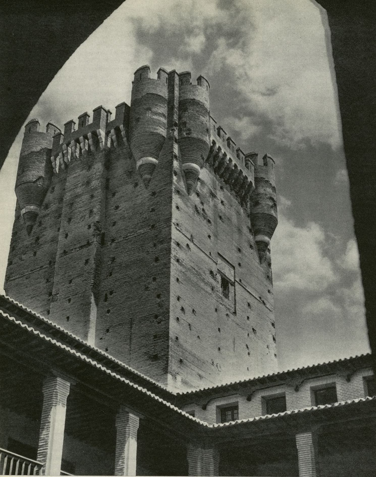
Torreón del Castillo de la Mota, en Medina del Campo (Valladolid)
