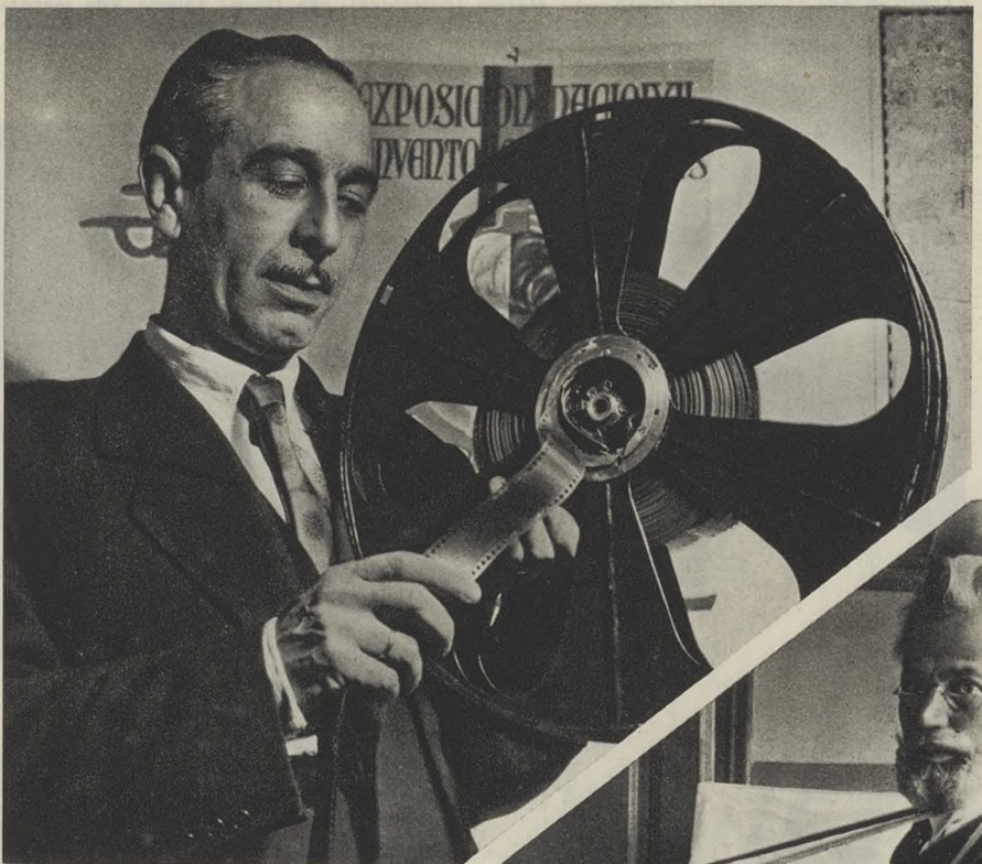
NUEVO SISTEMA DE BOBINA.—Los técnicos de la proyección cinematográfica saben lo que supone esta bobina con dispositivo interior, que permite volver a proyectar con una sola vuelta. Inventor, don Emilio Carretero, autor de otros inventos que se exponen.
