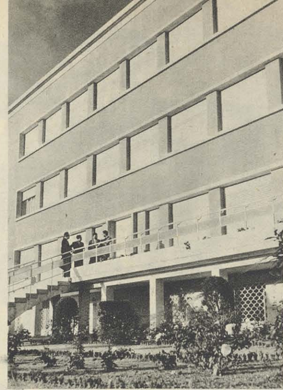
Una perspectiva del edificio de la Escuela, donde la línea de la moderna arquitectura funcional impone su jerarquía.
