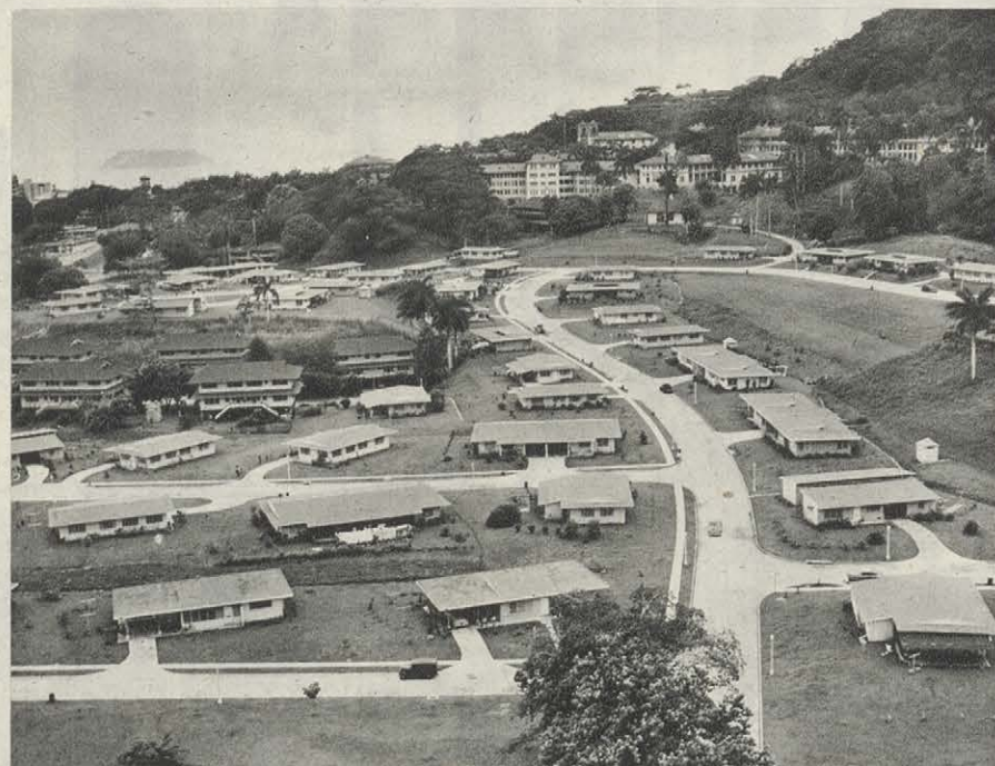
Una calle de Ancón, ciudad satélite del canal. Al fondo, el hospital Gorjas.
