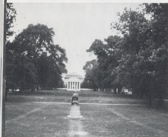
La Rotonda se eleva entre los árboles que rodean los prados encerrados por los claustros.
